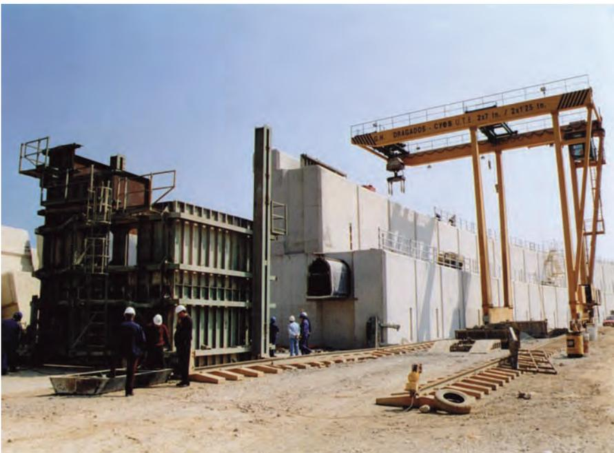
Figura 9.2.2 A Construcción espaldón con galería
