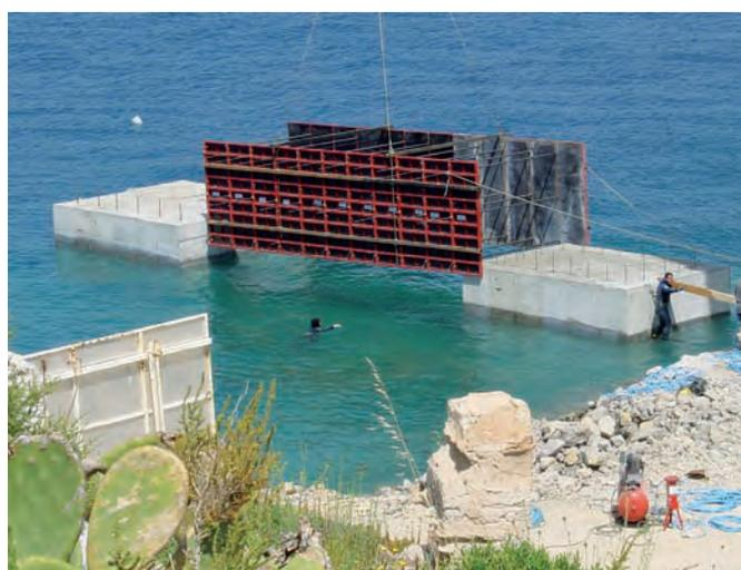
*Figura 10.5.1 K Encofrado a dos caras*
