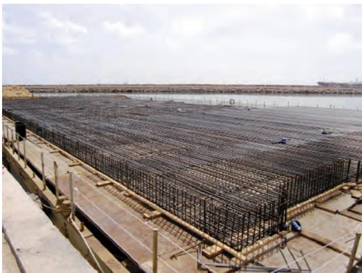
*Figura 6.12.5 Armadura solera*
