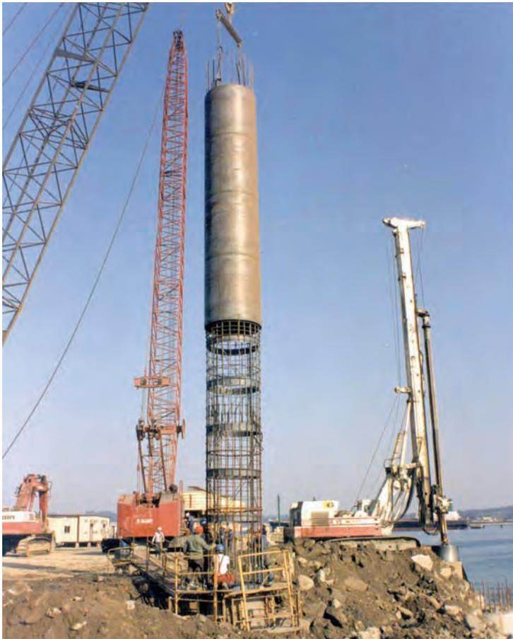
*Figura 8.2.2.b B Colocación de armaduras*
