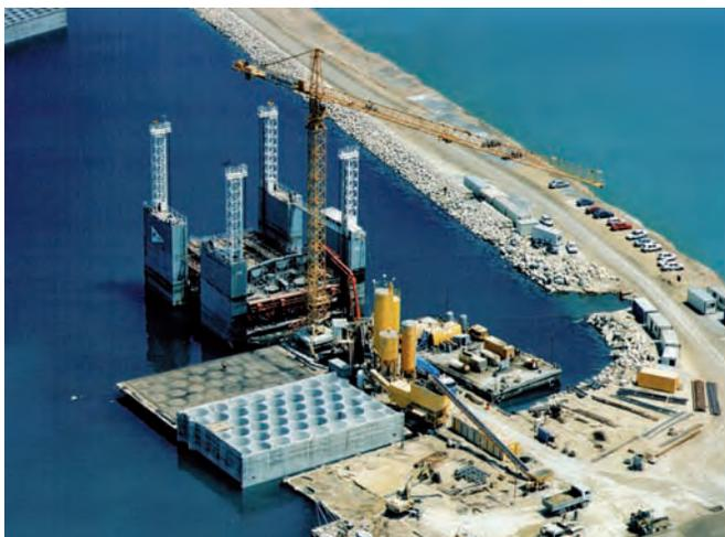
Figura 6.12.1 C Fabricación de cajones
