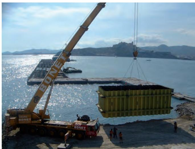
*Figura 10.5.1 J Encofrado a cuatro caras*
