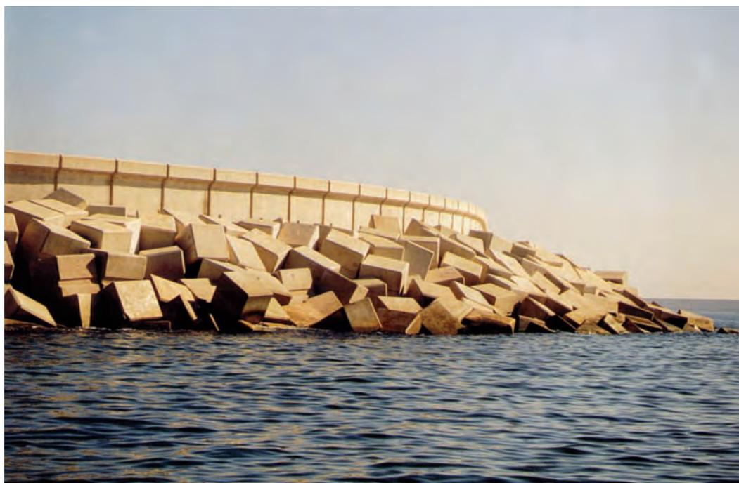
Figura 7.1.10.a Espaldón de dique en talud
