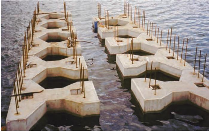
Figura 8.1.3.d A Encofrado perdido
