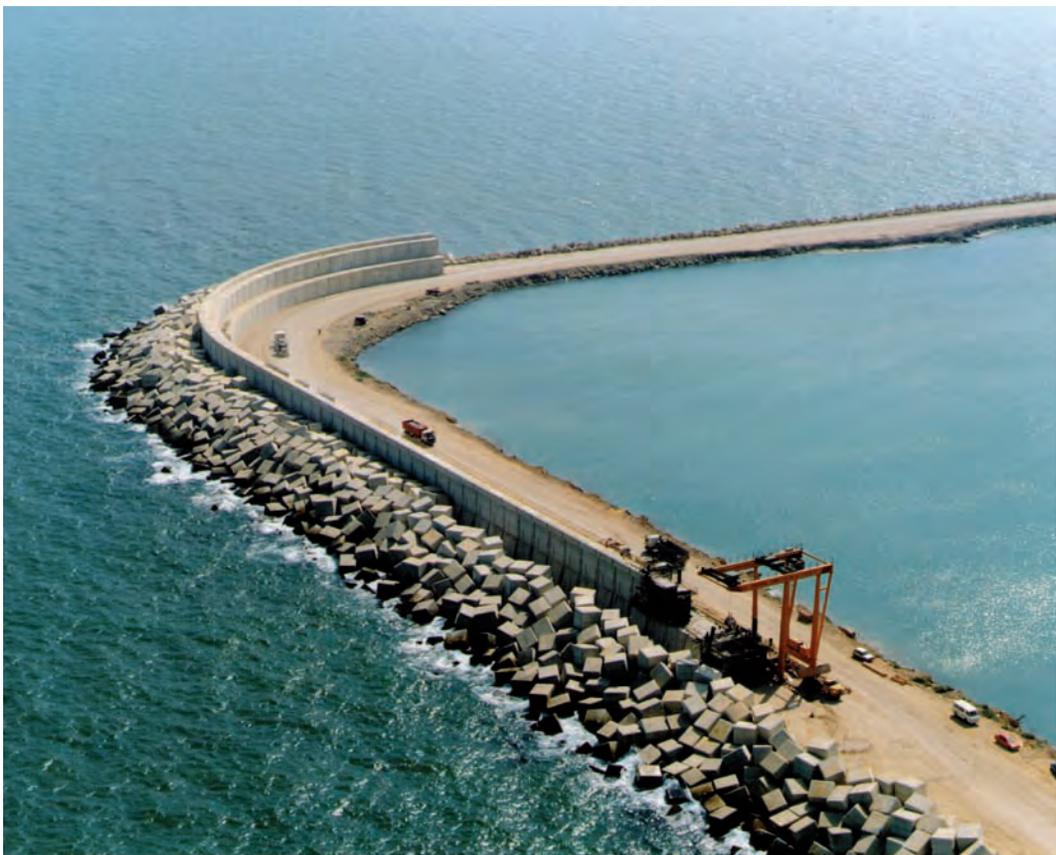
Figura 7.1.10.b Ejecución del espaldón del dique
