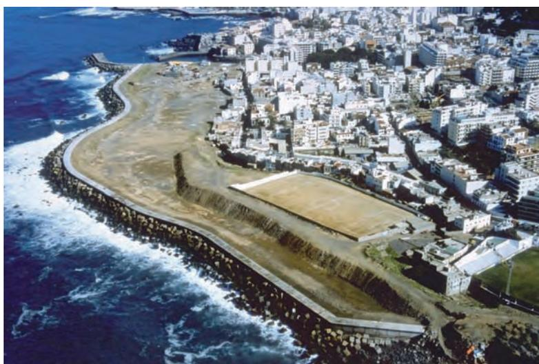
*Figura 6.10.2 B Manto de protección ante el oleaje*
