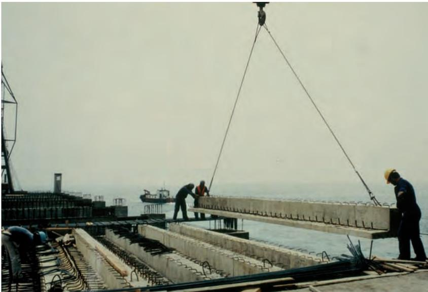
Figura 9.6.2 B Montaje de prefabricados
