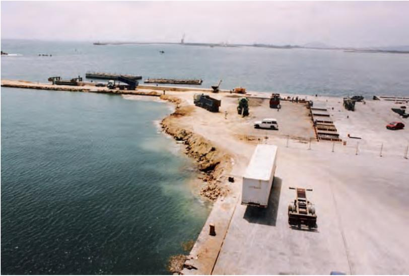
*Figura 6.2.1.b A Colocación de relleno*
