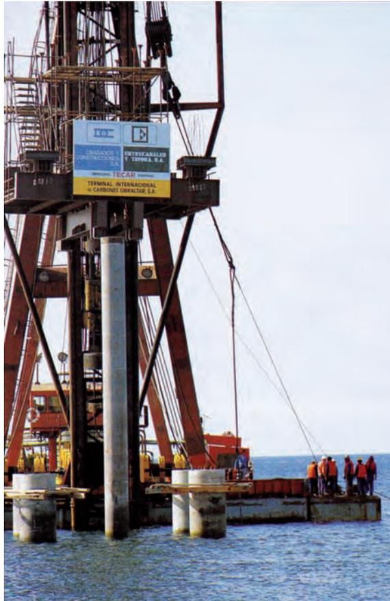
*Figura 8.2.5.f Prueba de carga*
