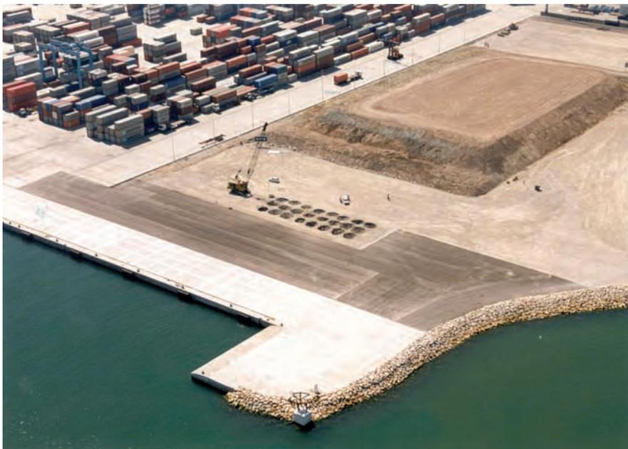
Figura 6.3.5 A Compactación dinámica y precarga
