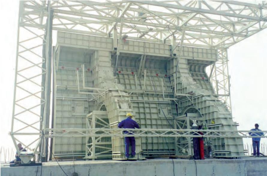
Figura 9.3.3 C Encofrado de espaldón de hormigón armado
