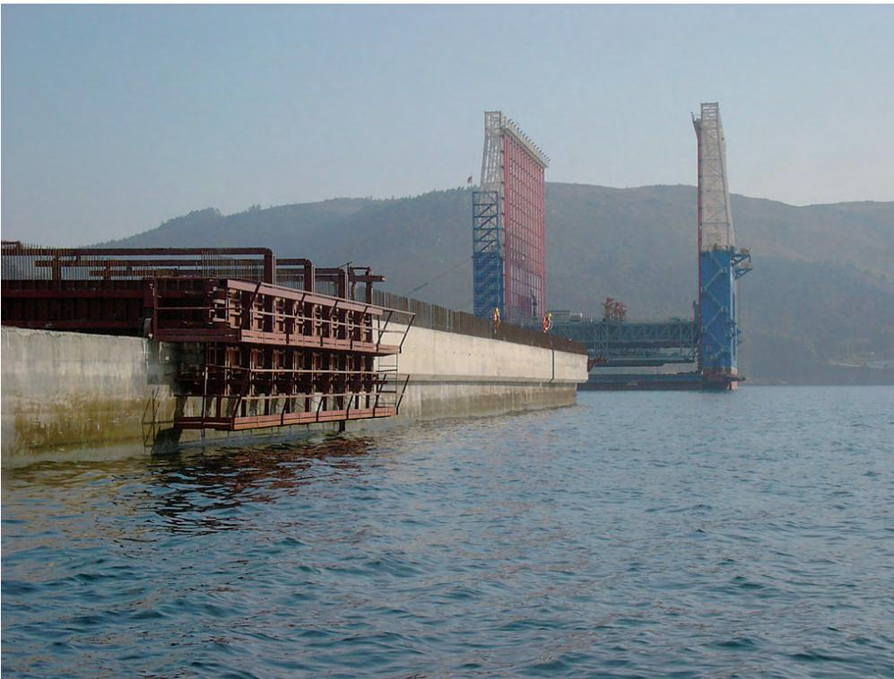
*Figura 9.4.3 B Encofrado viga cantil*
