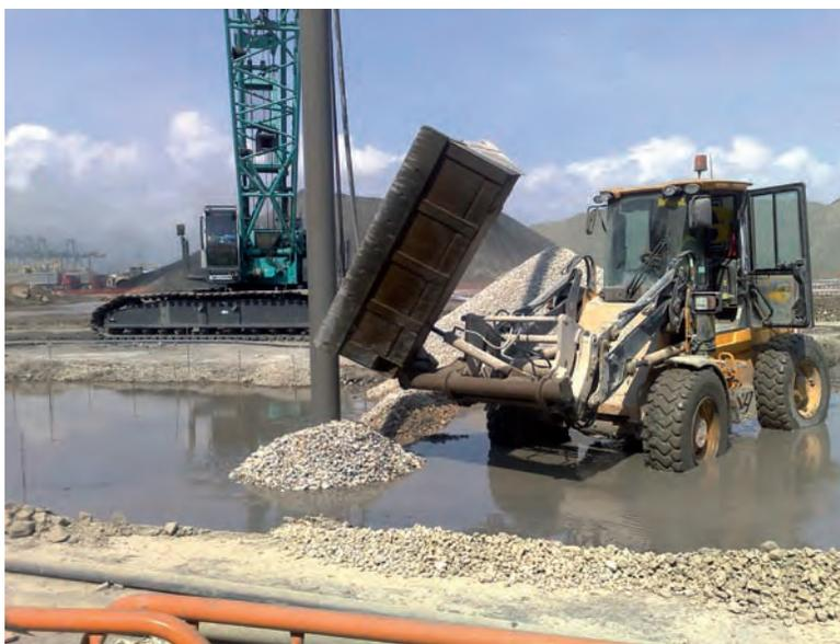
*Figura 6.3.7 B Ejecución Columnas de grava en tierra*
