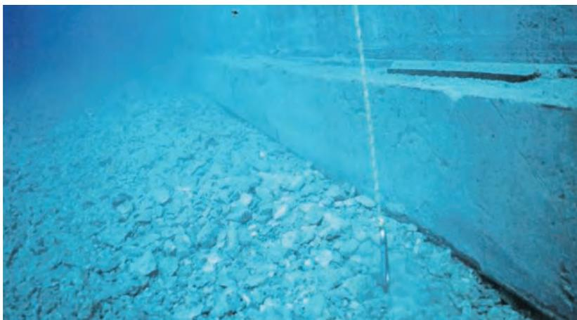
*Figura 6.8.4 Comprobación del enrase tras fondear el cajón*
