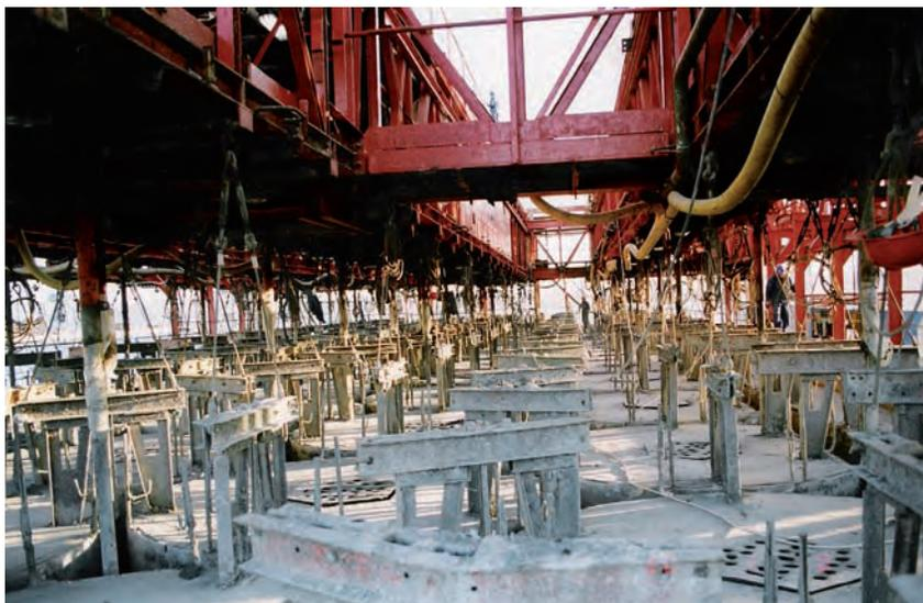
*Figura 6.12.2 B Encofrados*
