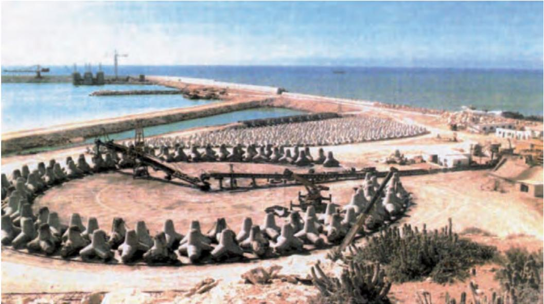
Figura 6.11.2 E Parque circular de fabricación de Tetrápodos
