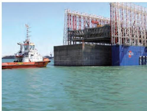
Figura 6.12.7 B Botadura del cajón
