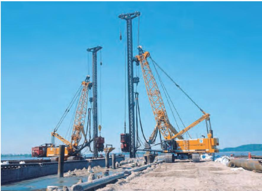
Figura 6.3.6 A Columnas encapsuladas
