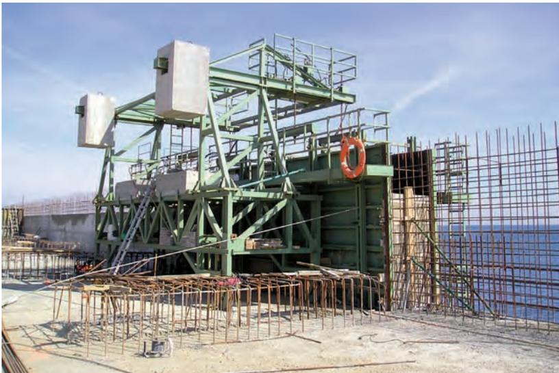
Figura 9.4.3 A Encofrado viga cantil
