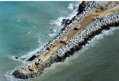
Figura 7.1.3 A Avance de un dique en construcción
