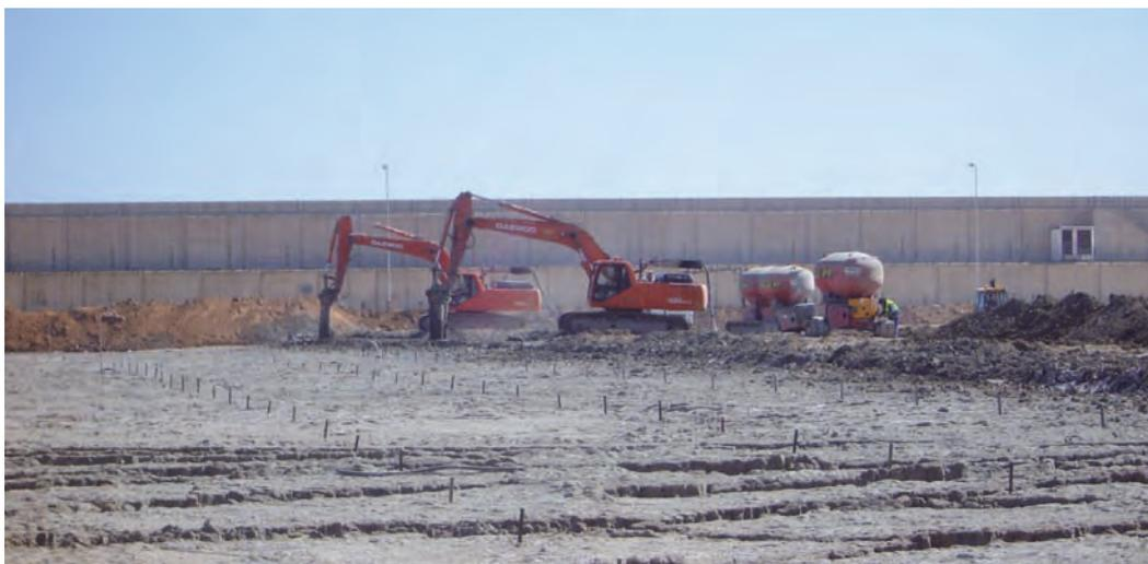
*Figura 6.3.8 C Replanteo de celdas de tratamiento*
