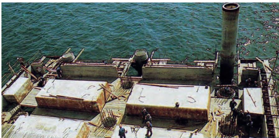
Figura 9.6.2 C Superestructura hormigonada “*in situ*”
