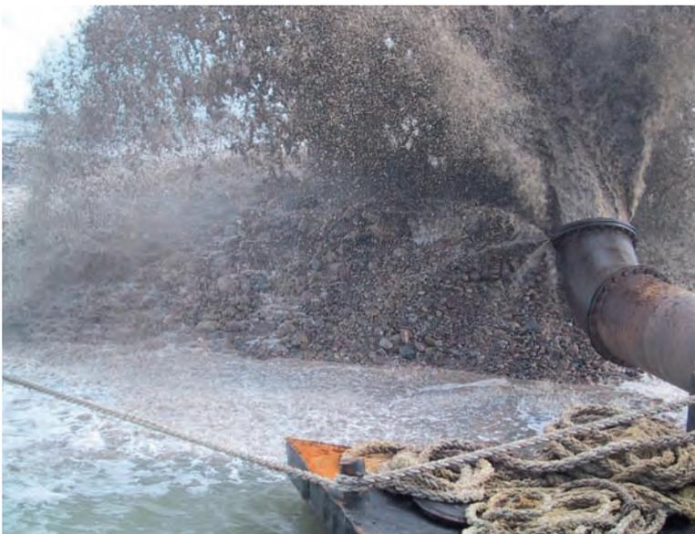
*Figura 6.2.2.b B Relleno hidráulico*
