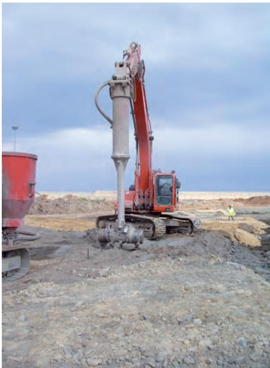
*Figura 6.3.8 B Mezclador para estabilización en masa*
