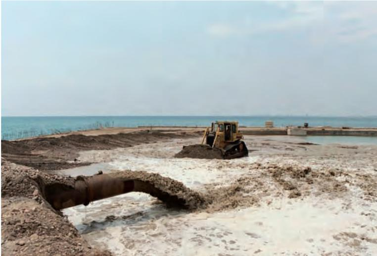
*Figura 6.2.2.b A Relleno con tubería*
