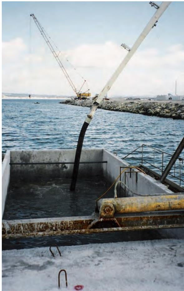
Figura 8.1.3.e Hormigonado con bomba
