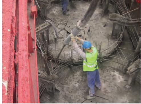
Figura 6.12.6 B Hormigón del fuste
