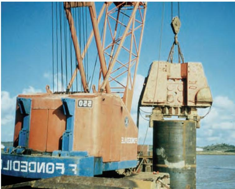
*Figura 8.2.5.e B Hinca de pilote metálico con martillo vibrador*
