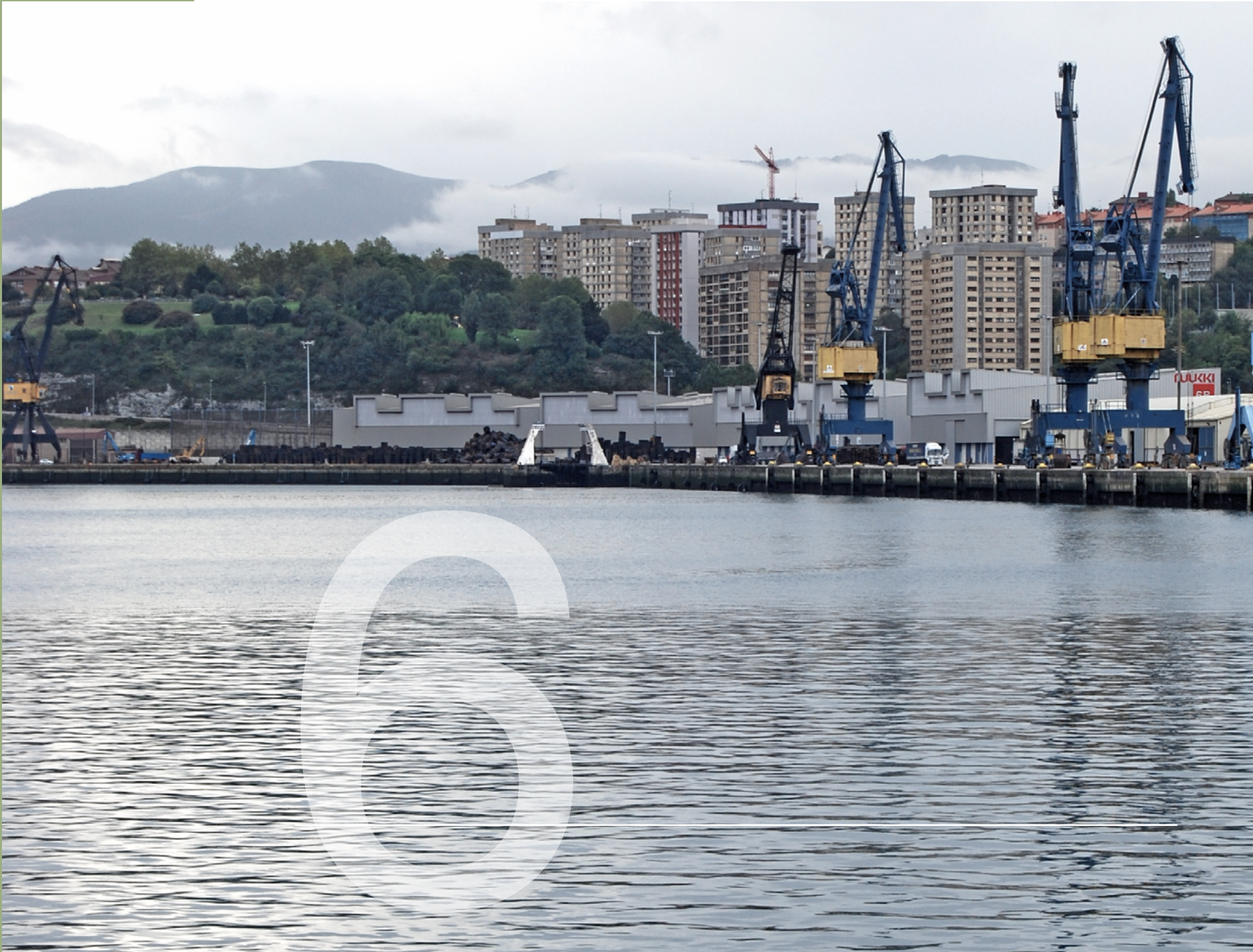
Construcción de pabellón 8 en el Muelle de Molinao del Puerto de Pasaia
