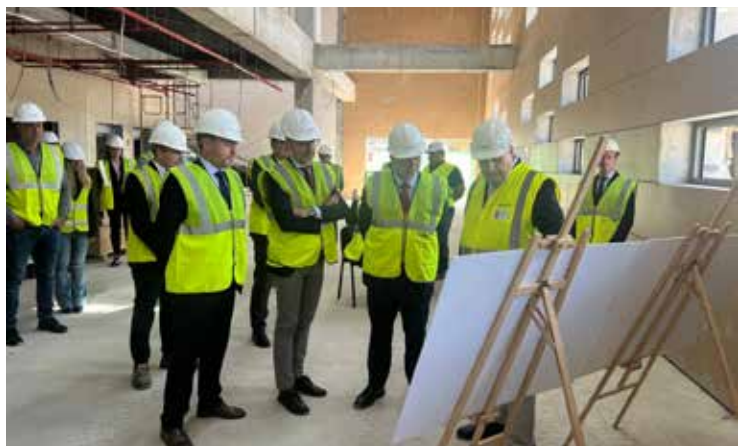
5. Visita del ministro de Política Territorial a las obras de la estación marítima del puerto de Ceuta. / The Minister of Territorial Policy visited the Ceuta Port's maritime station construction site.
