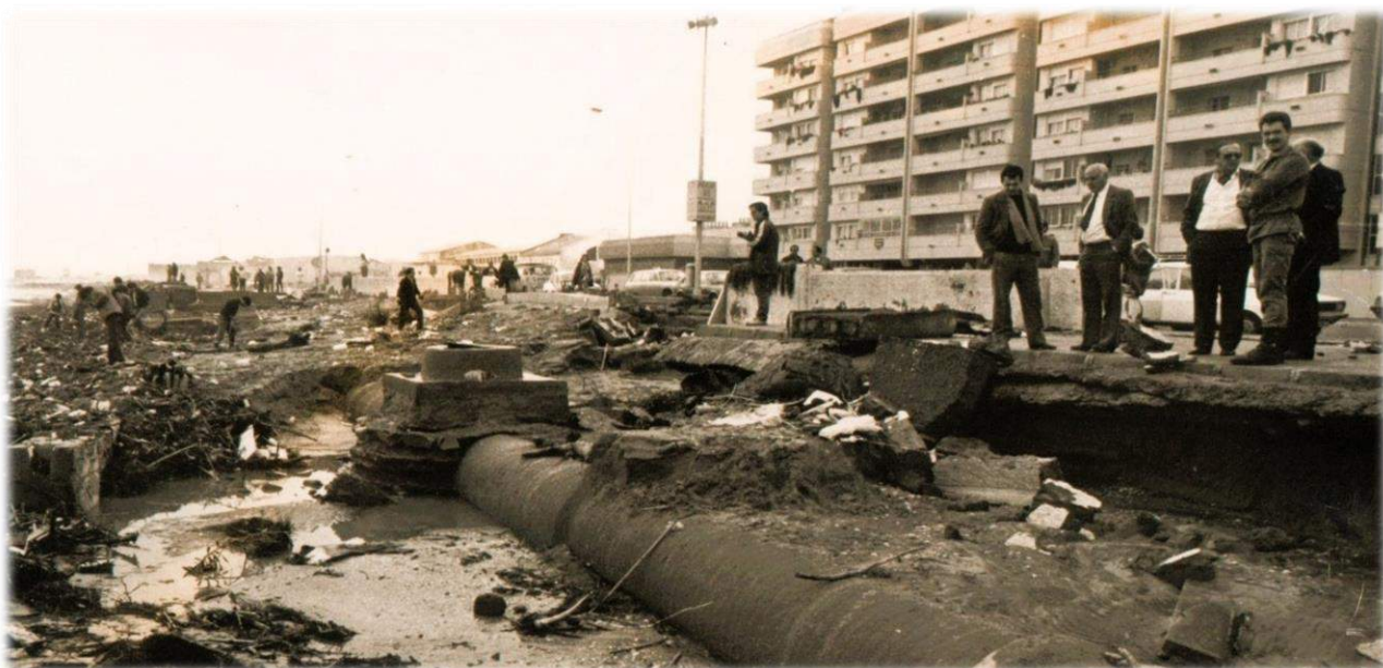
Daños ocasionados por el temporal. Archivo APM. Año 1985
