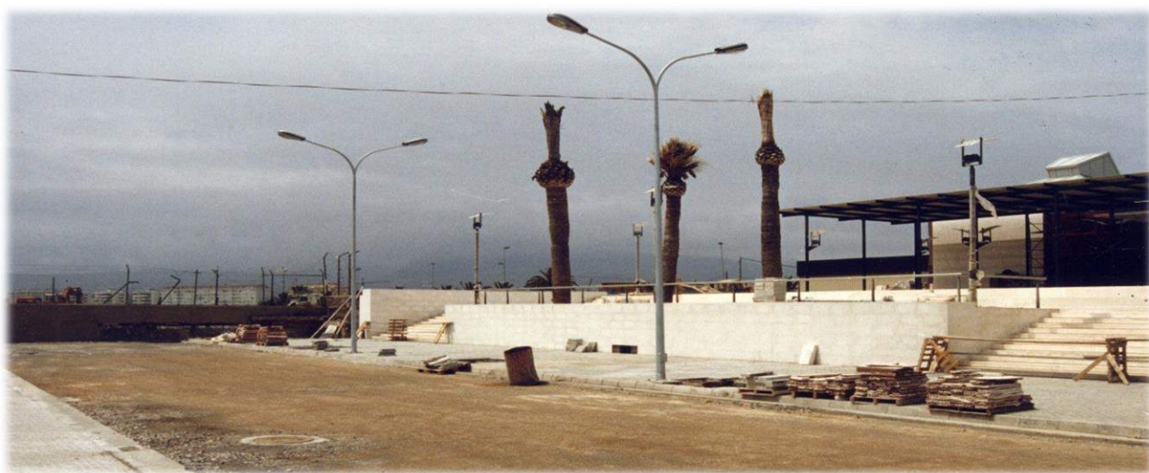
Construcción vial comunicación P. España -Paseo Marítimo. Archivo APM. Año1995
