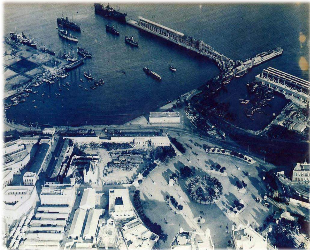
Construcción del Cargadero de Mineral y vista de la antigua Dársena de Pesqueros (hoy Explanada de Santa Bárbara) Archivo Juan Díez. Año 1922-1924
