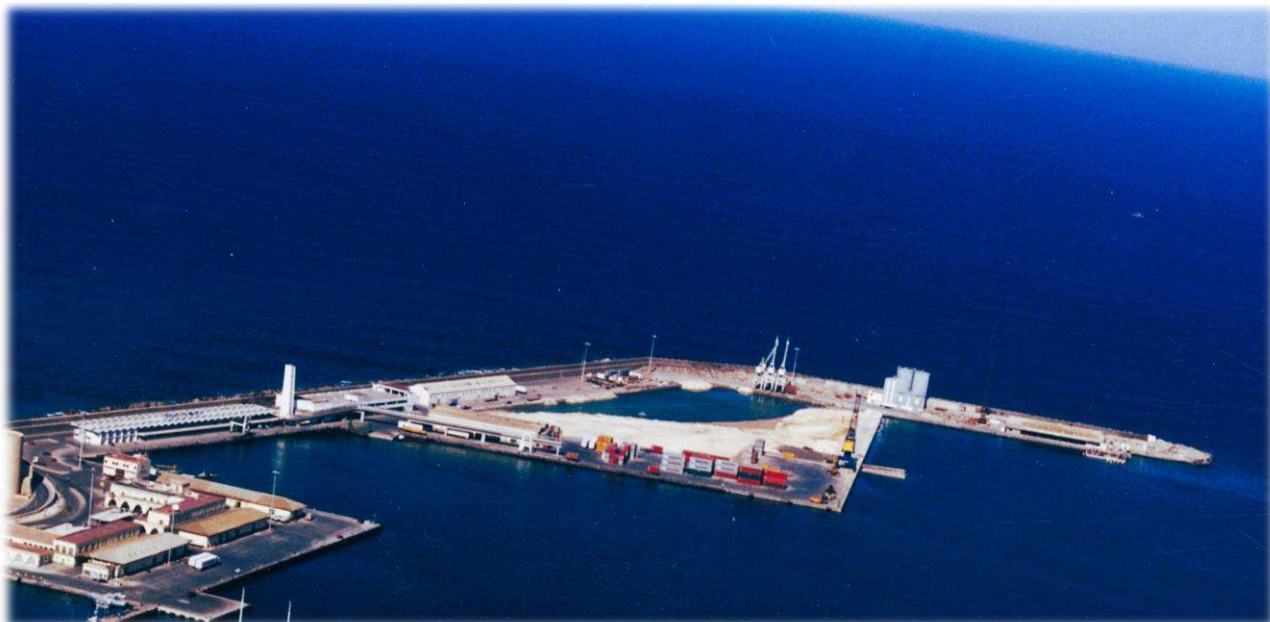
Relleno de muelle Nordeste II y ampliación del dique Nordeste III. Archivo APM. Año 1999
