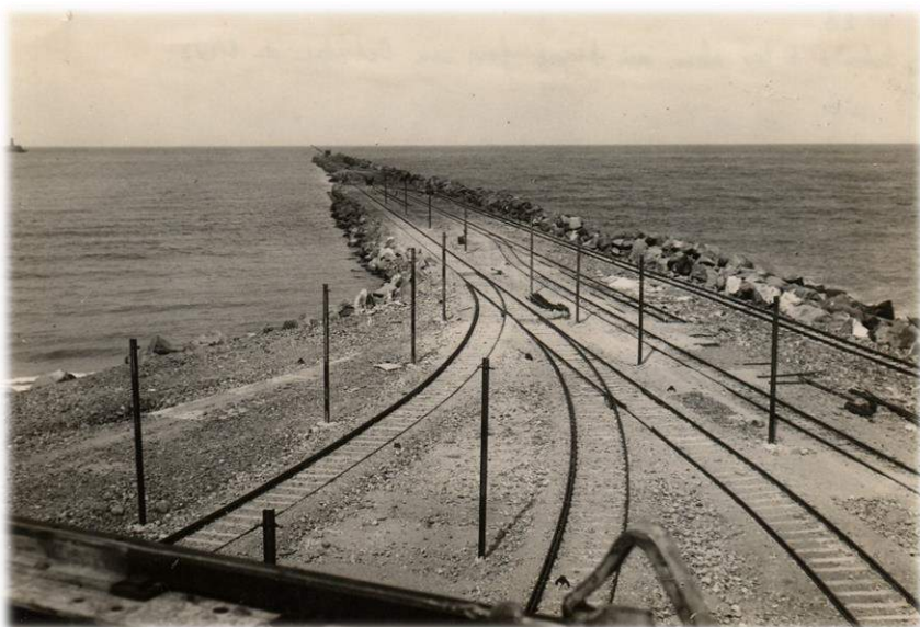
Estado de las obras del Dique Sur. Archivo APM. Año 1942
