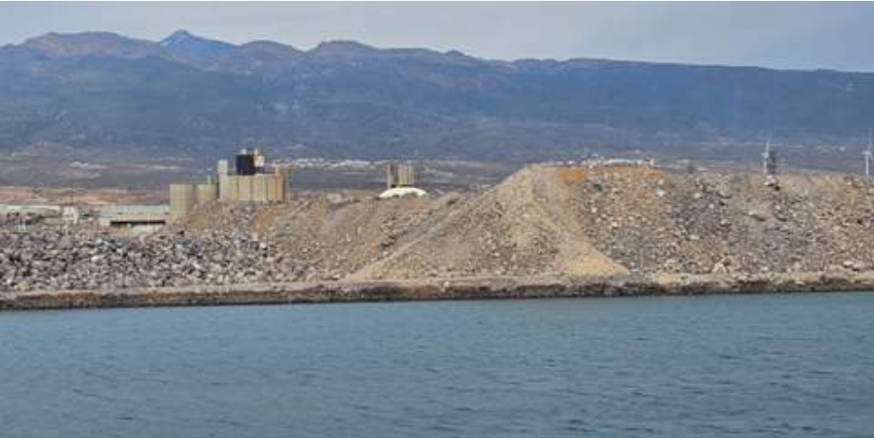
Acopios de TÚno y Escoleras generados
