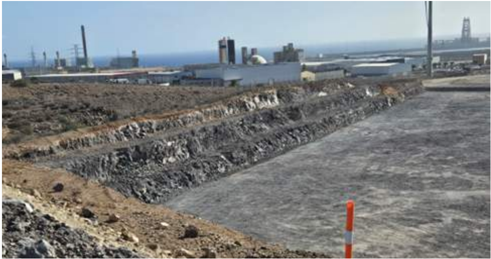
Acondicionamiento de taludes
