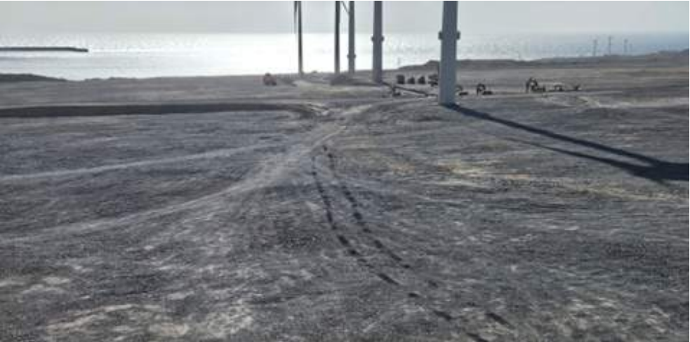
Explanadas de Plataformas terminadas 2
