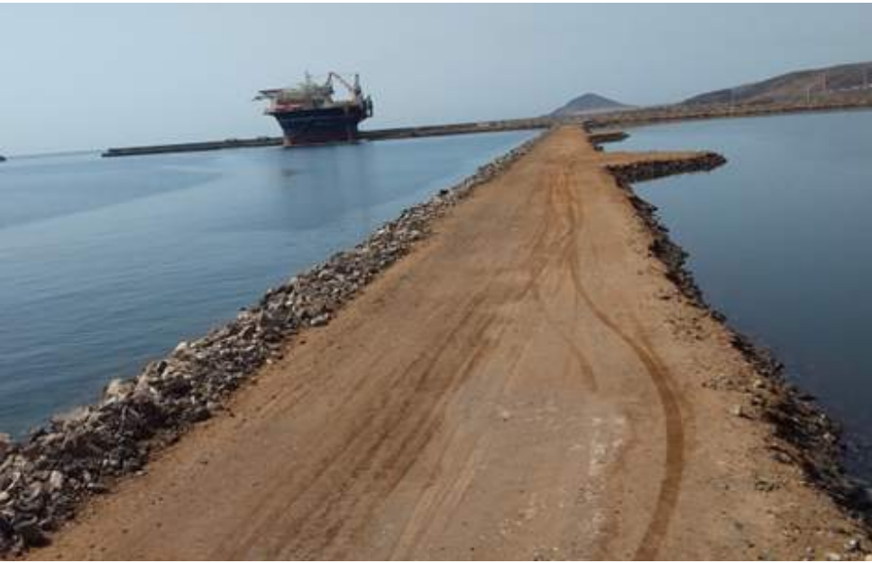
Dique de cierre de recinto terminado
