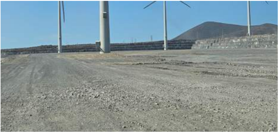
Explanadas de Plataformas terminadas 1
