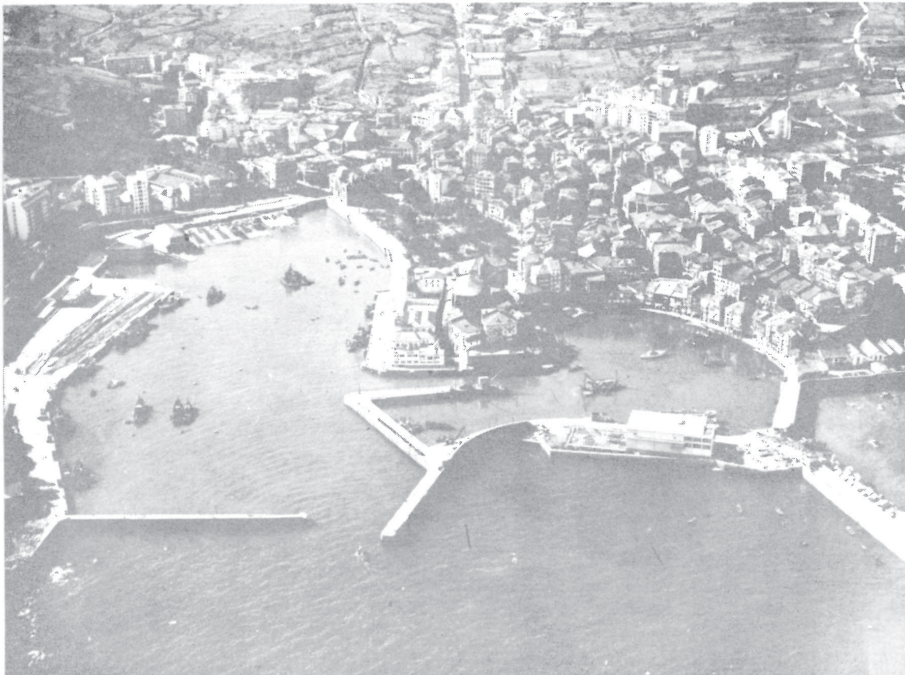
PUERTO DE BERMEO
