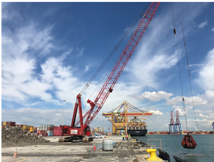
Pavimentación e infraestructuras de la explanada del muelle Norte (Sitá) del puerto de Valencia
