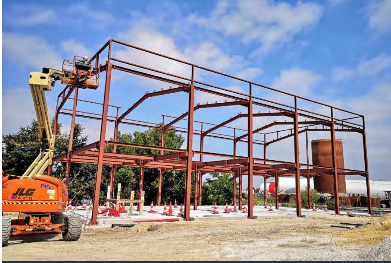
Montaje de la Estructura metálica del edificio Assembly of the metallic Structure of the building
