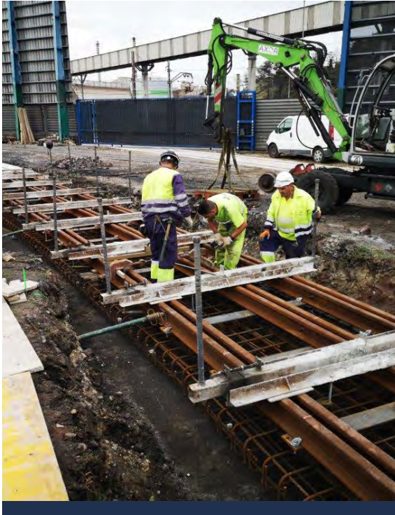
Ejecución de vía en placa Implementation of slab track
