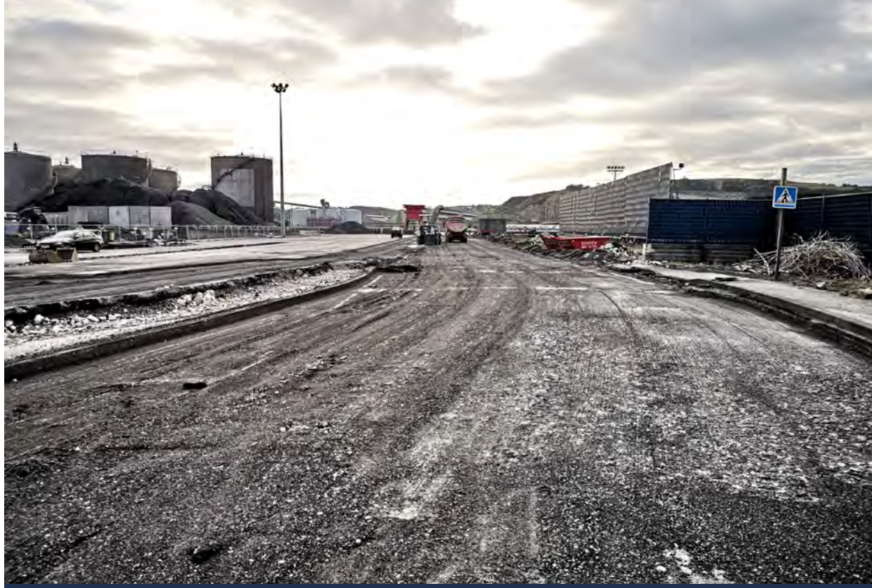
Vista general de la demolición y fresado del firme existente (diciembre de 2020) Overview of demolition and milling of existing roadbed (December 2020)
