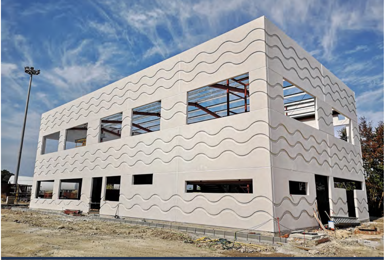
Montaje del panel de hormigón prefabricado de fachada del Edificio Assembly of the prefabricated concrete panel on the Building façade
