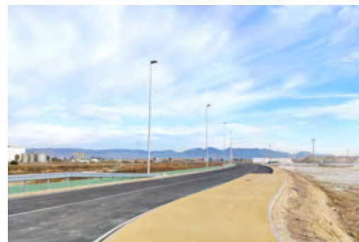
▶ Tramo vial previo al paso sobre el canal
