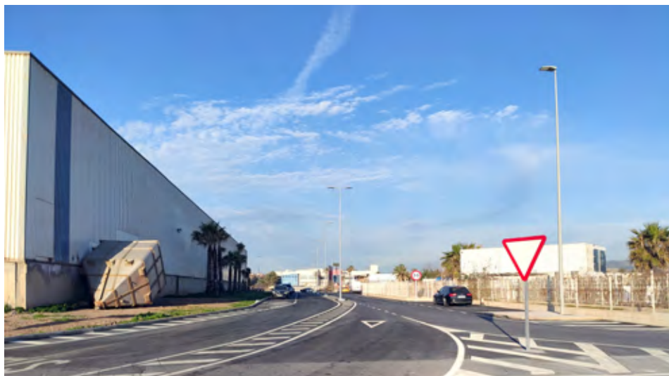
► Vial junto a dique norte
