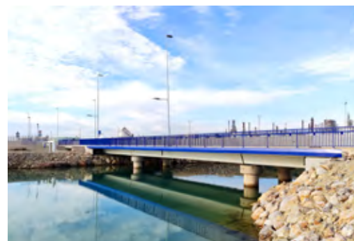
▶ Paso superior sobre el canal
