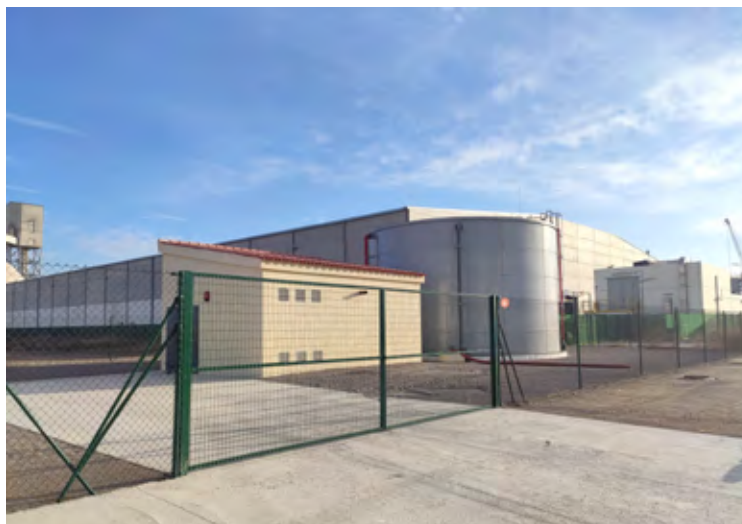
► Caseta de bombas y depósito
