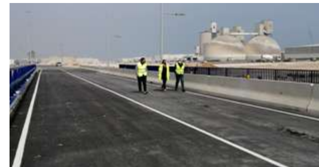
Entra en funcionamiento el puente sobre el canal de Iberdrola
