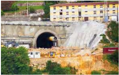
Emboquille del túnel en A Graña
