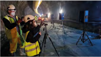
Control de ruido en la obra del túnel
