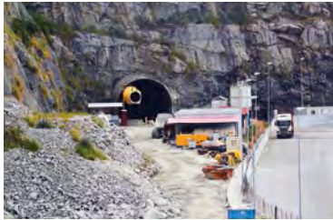
Emboquille del túnel en Puerto Exterior
