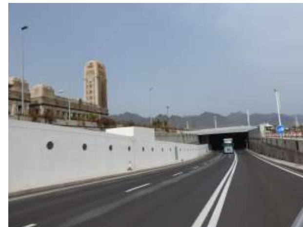
REPOSICIÓN DE TUBERÍAS DE COMBUSTIBLE. PUERTO DE SANTA CRUZ DE TENERIFE
