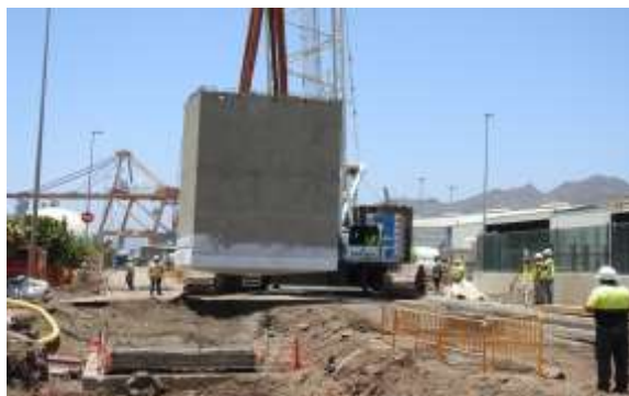
SANEAMIENTO DE LA DÁRSENA DE CUEVA BERMEJA DEL PUERTO DE SANTA CRUZ DE TENERIFE
