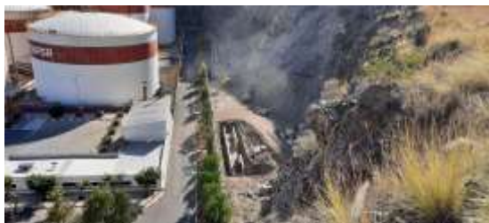
TRATAMIENTO DE LADERA Y CANALIZACION DE DESAGÜE EN LA ZONA DE SERVICIOS PORTUARIOS DE LA JURADA. SANTA CRUZ DE TENERIFE
