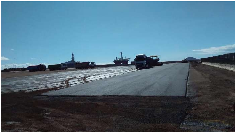
Asfaltado de la explanada provisional
