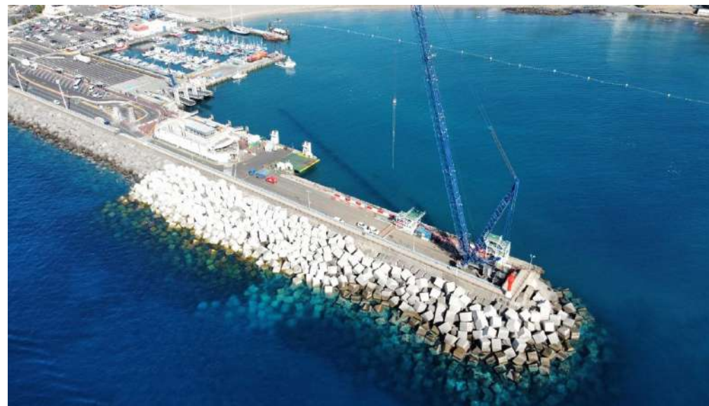
Refuerzo de bloques en la posición 1
