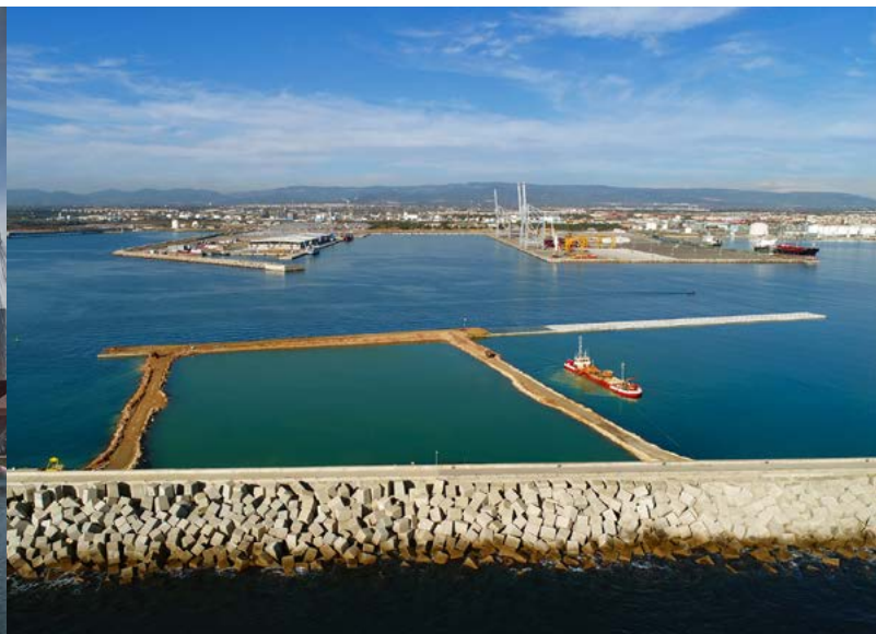
El muelle de Balears cierra el dique norte para iniciar el dragado Closure of the Balears Wharf northern breakwater to begin dredging
