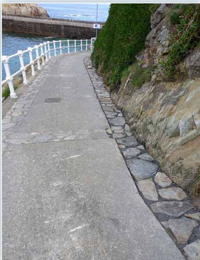
Vistas de las obras una vez finalizadas. Scenes from the works on completion.
