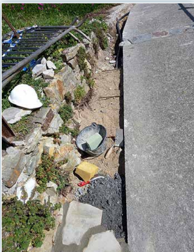
Vistas de las obras durante la ejecución. Scenes from during the works.
