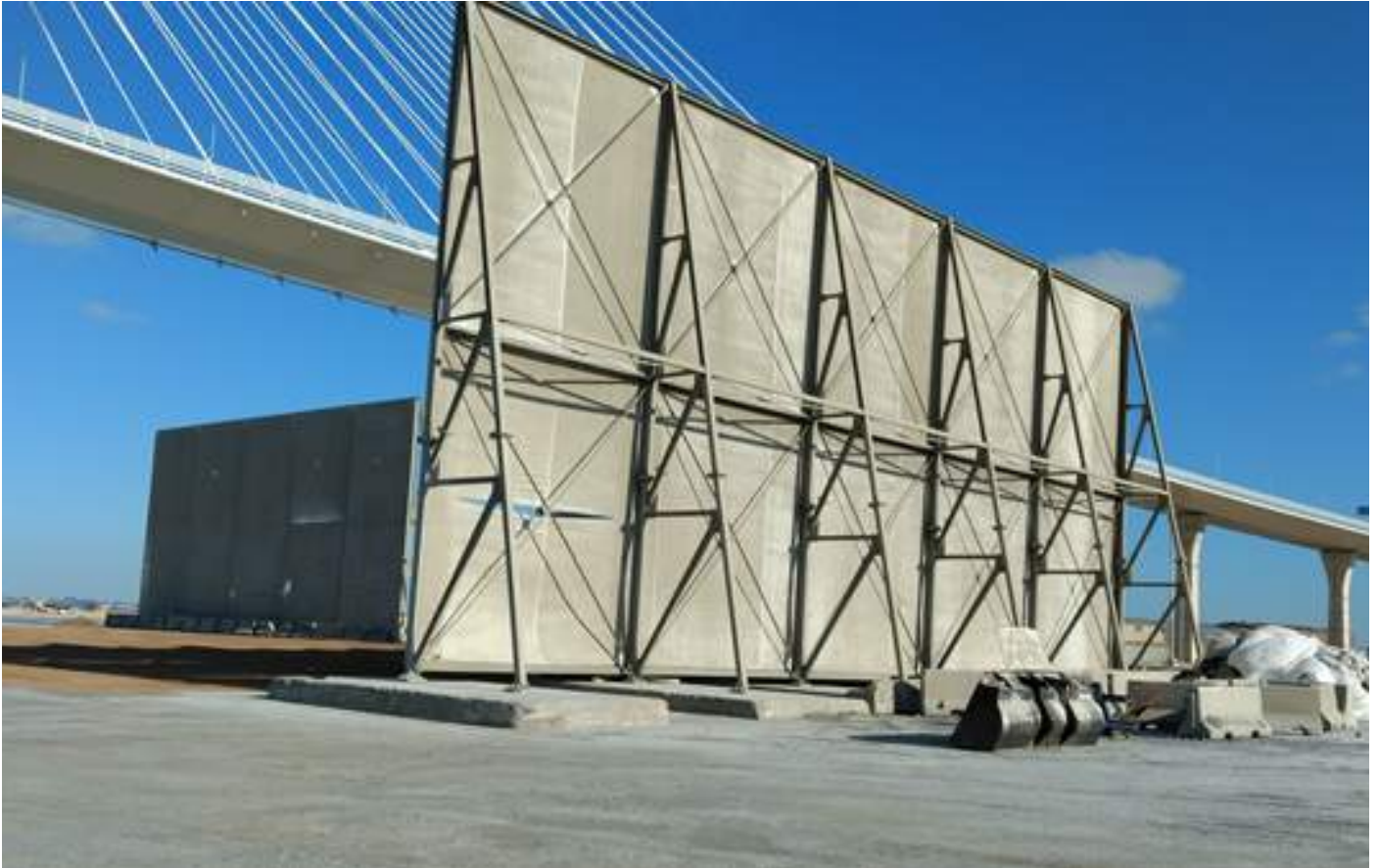
Barreras cortavientos en el muelle Cabezuela Oeste. Wind barriers on the Western Cabezuela quay.
