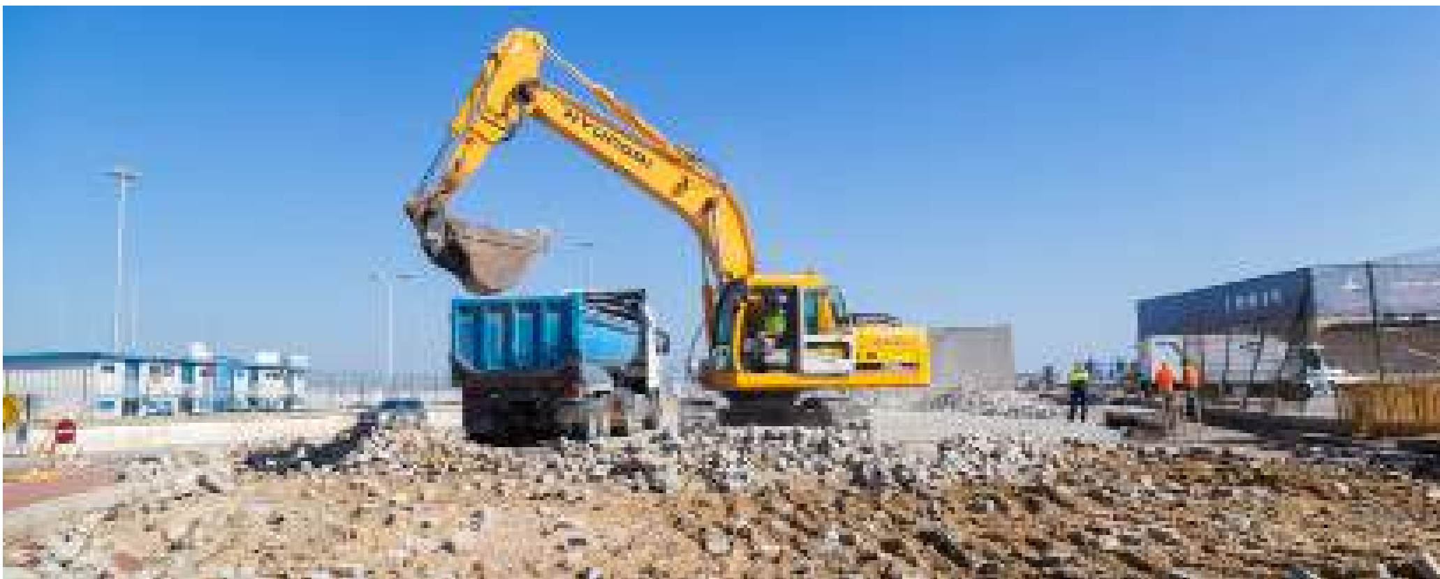
Obras de pavimentación y reordenación del recinto pesquero.
