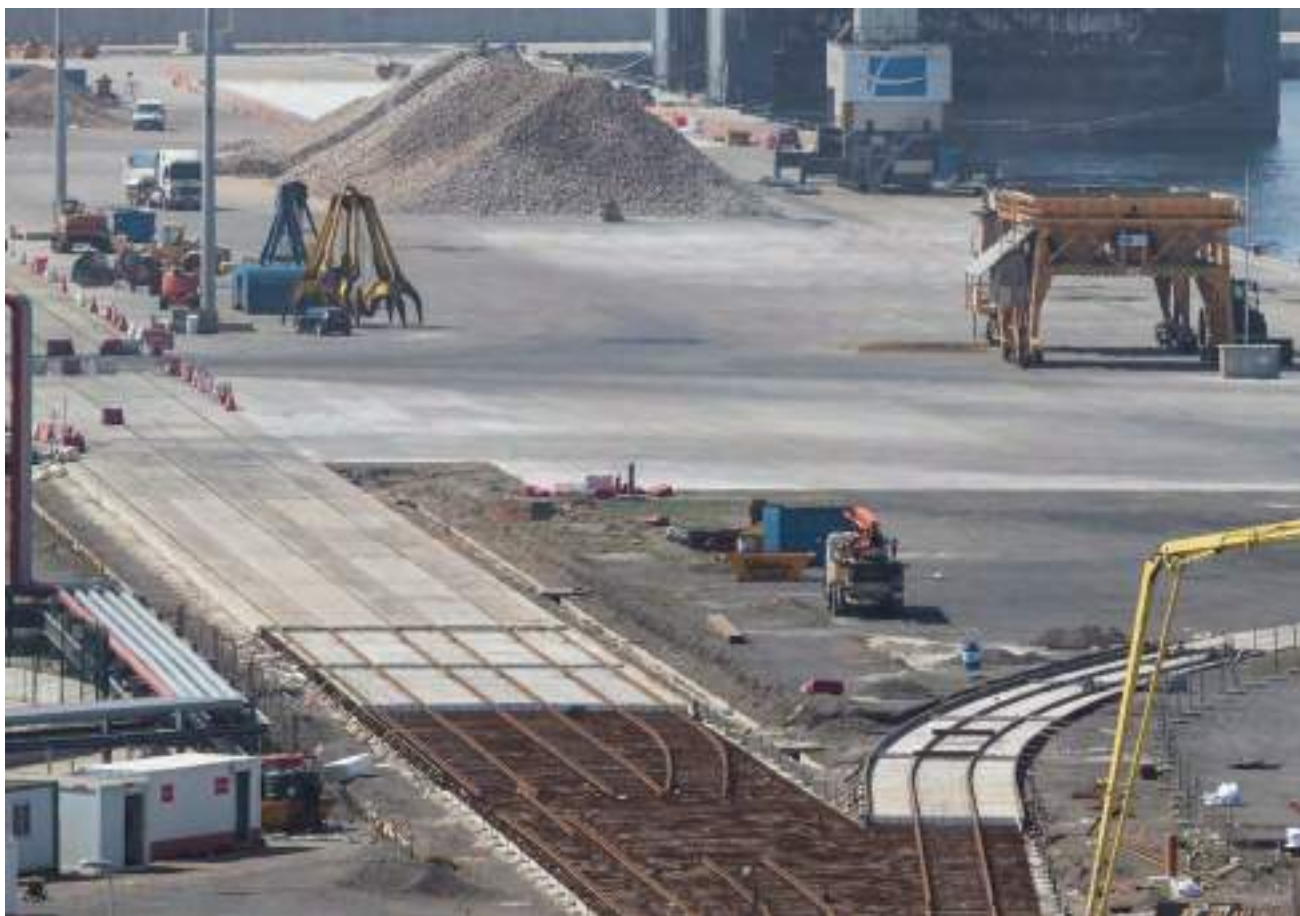
Acceso Ferroviario a la Ampliación de la dársena de Escombreras Tramo I. Railway Access to the Extension of the Escombreras Dock, Section I.
