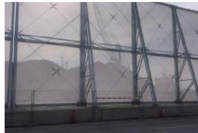
16 de octubre. Pantallas corta-viento para impedir el arrastre de partículas por acción del viento.
