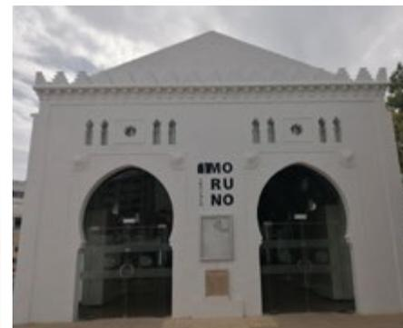
Se ha llevado a cabo un pintado a dos manos de toda la fachada. Se ha adecuado y pintado toda la carpintería y se ha realizado un tratamiento de reparación y pintura mediante esmalte sintético antioxidante de todas las rejas de ventana. Por último, se ha revestido el interior con piezas de azulejo artesano.
