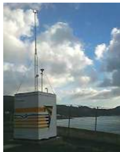
Estación de control de partículas Puerto Exterior
