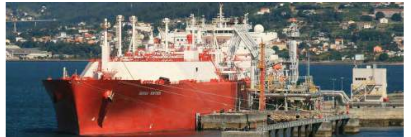
Terminal de gas natural.
