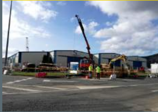
Obras de desdoblamiento de la red de saneamiento y conexión al colector municipal.
