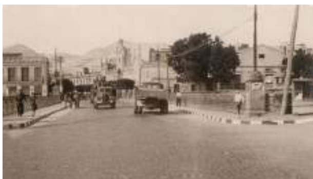
ACCAM, signatura: 625.745.1, nº 4.421, Puente del General Marina, 1966.
