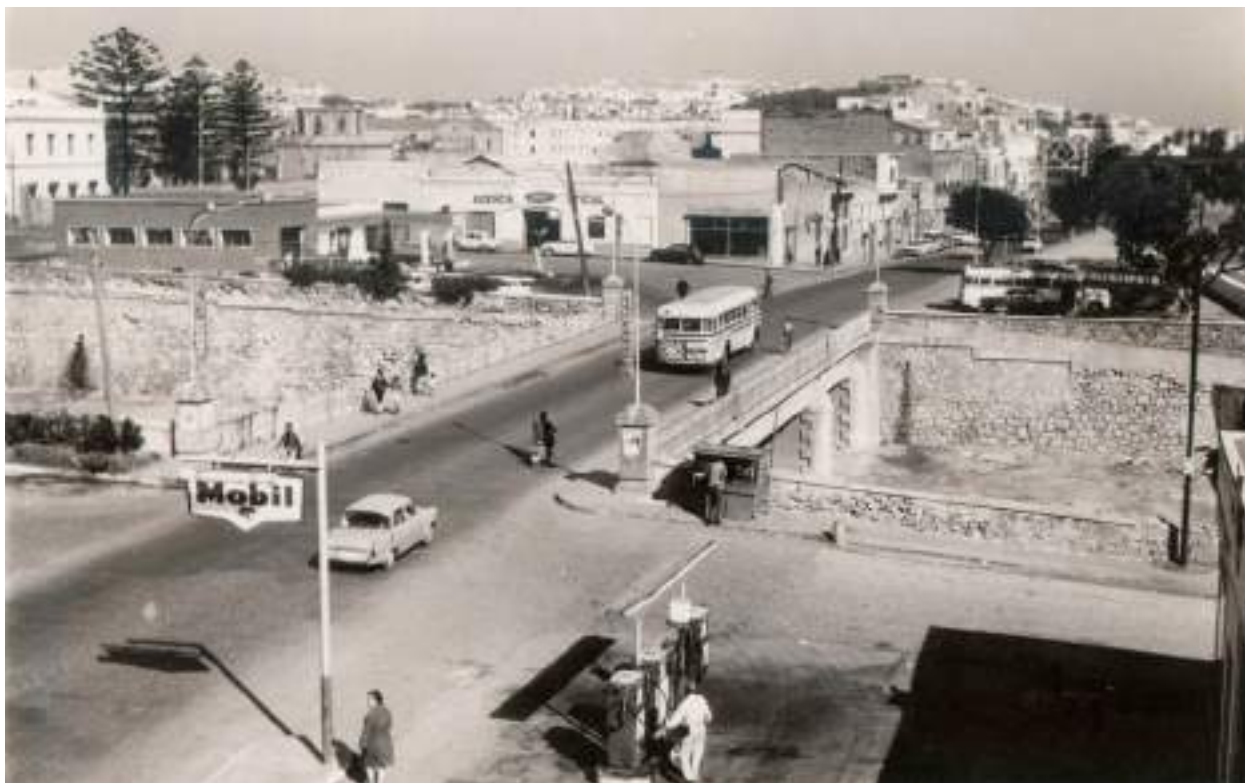
ACCAM, signatura: 625.745.1, nº 5.863, Puente del General Marina, 1953.
