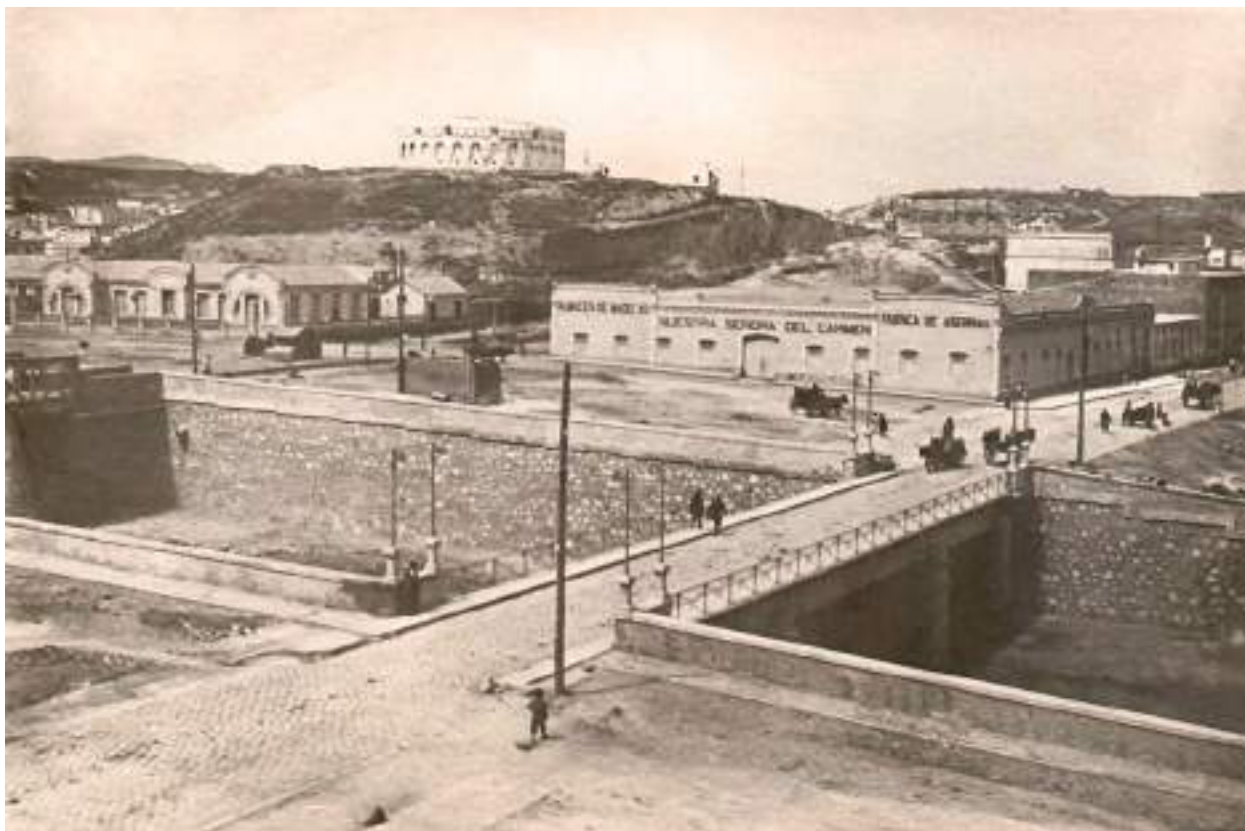
ACCAM, signatura: 625.745.1, nº 4.420, Puente del General Marina, 1917.
