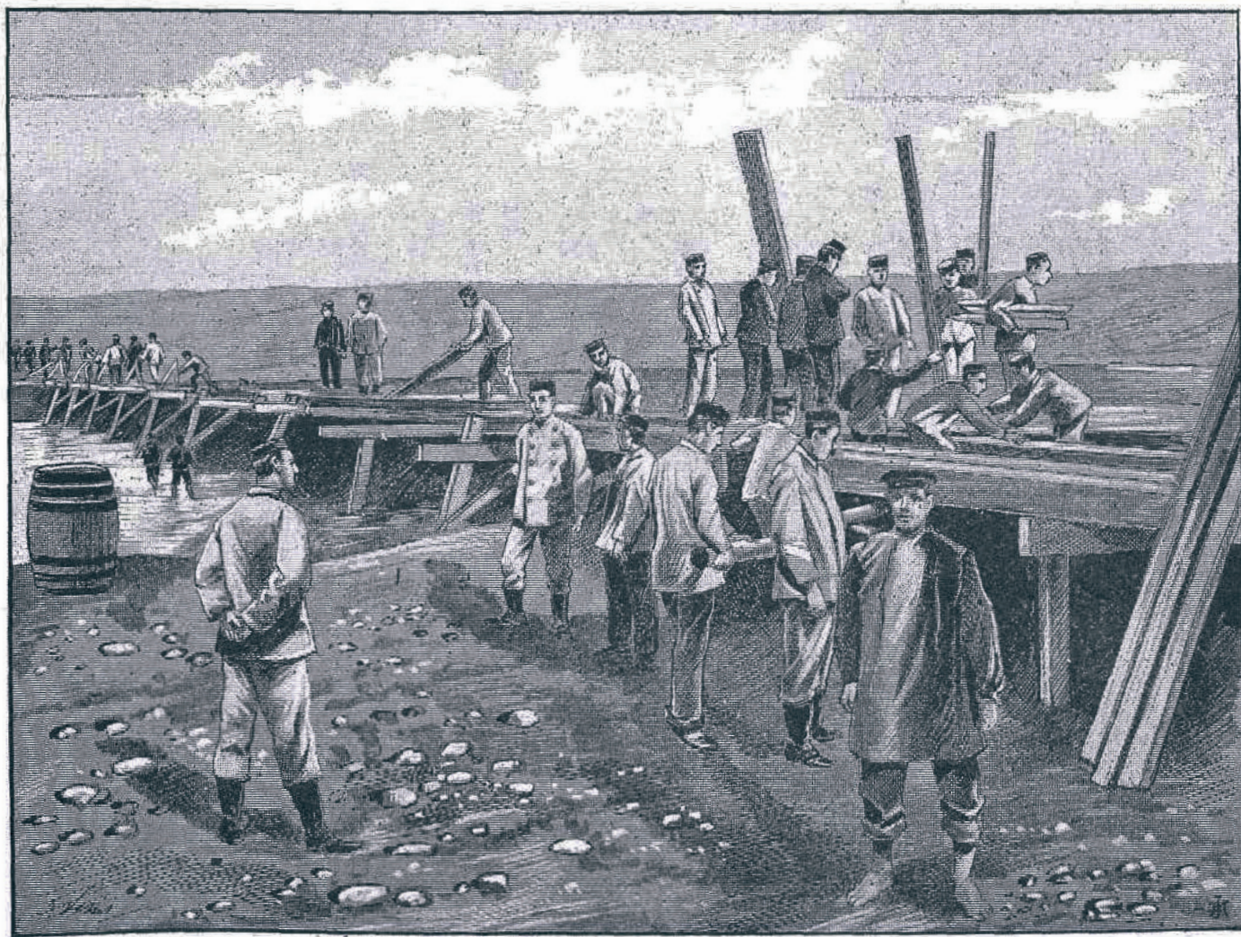
INGENIEROS CONSTRUYENDO UN PUENTE DE TABLONES SOBRE EL RÍO DE ORO
