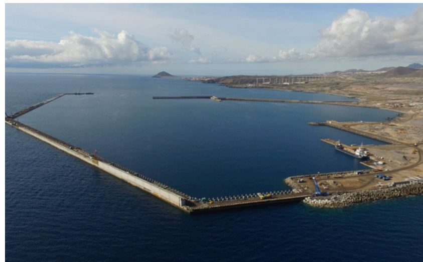
Foto 3.- Vista de la unión del dique en talud con el dique vertical y el ensanche de explanada
