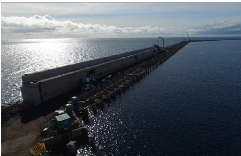
Foto2.- Vista del avance del espaldón en la segunda alineación del dique exterior
