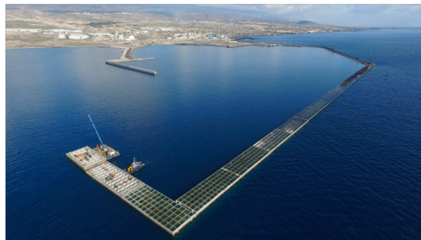
Foto 1.- Vista de conjunto de las obras a finales de 2016
