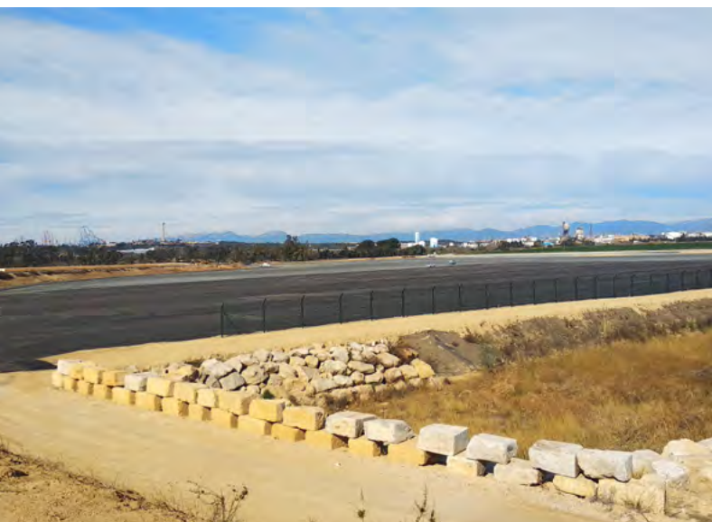
Obras de asfaltado de la ZAL. ZAL asphalting work.
