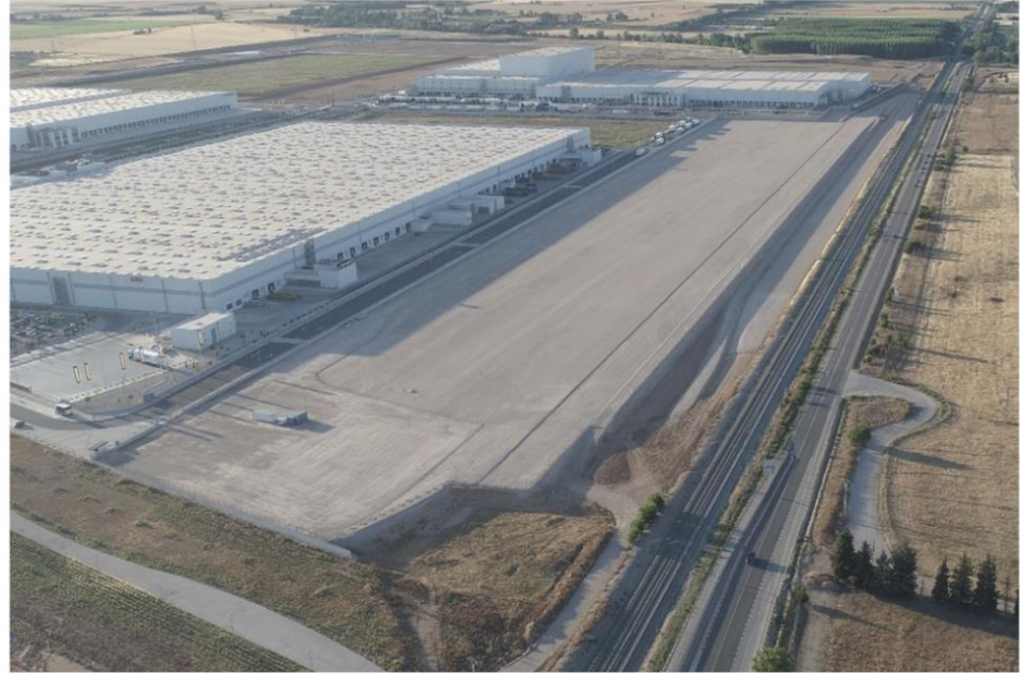
Fotografías estado final (junio 2022)
