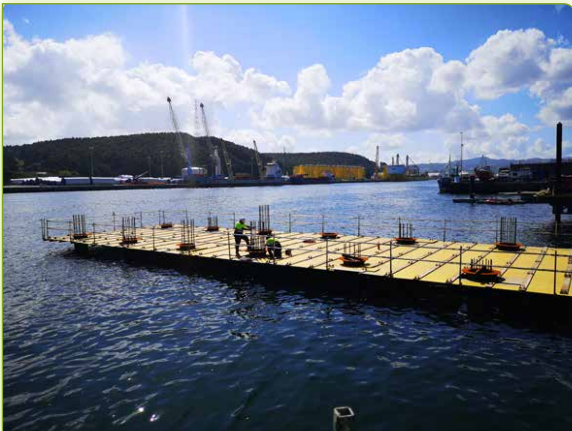
Antes de las obras.
