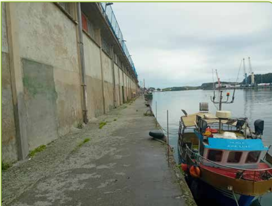
Antes de las obras. Before the works.
