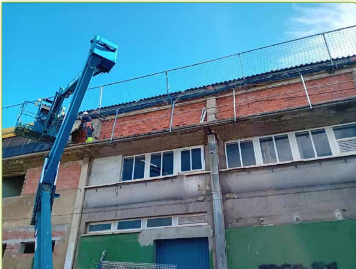
Fachada antes de las obras. Julio 2023.
