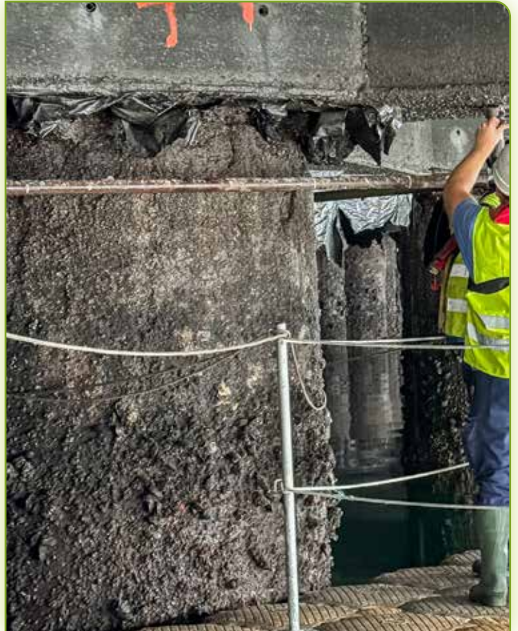
Antes de las obras. Before the works.
