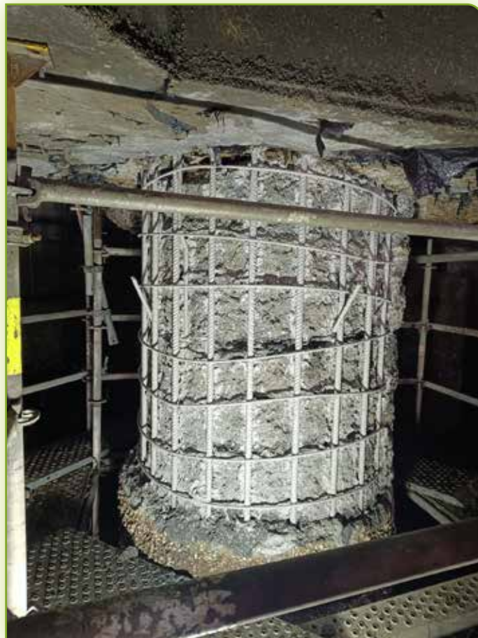
Durante la ejecución de las obras. During the works.
