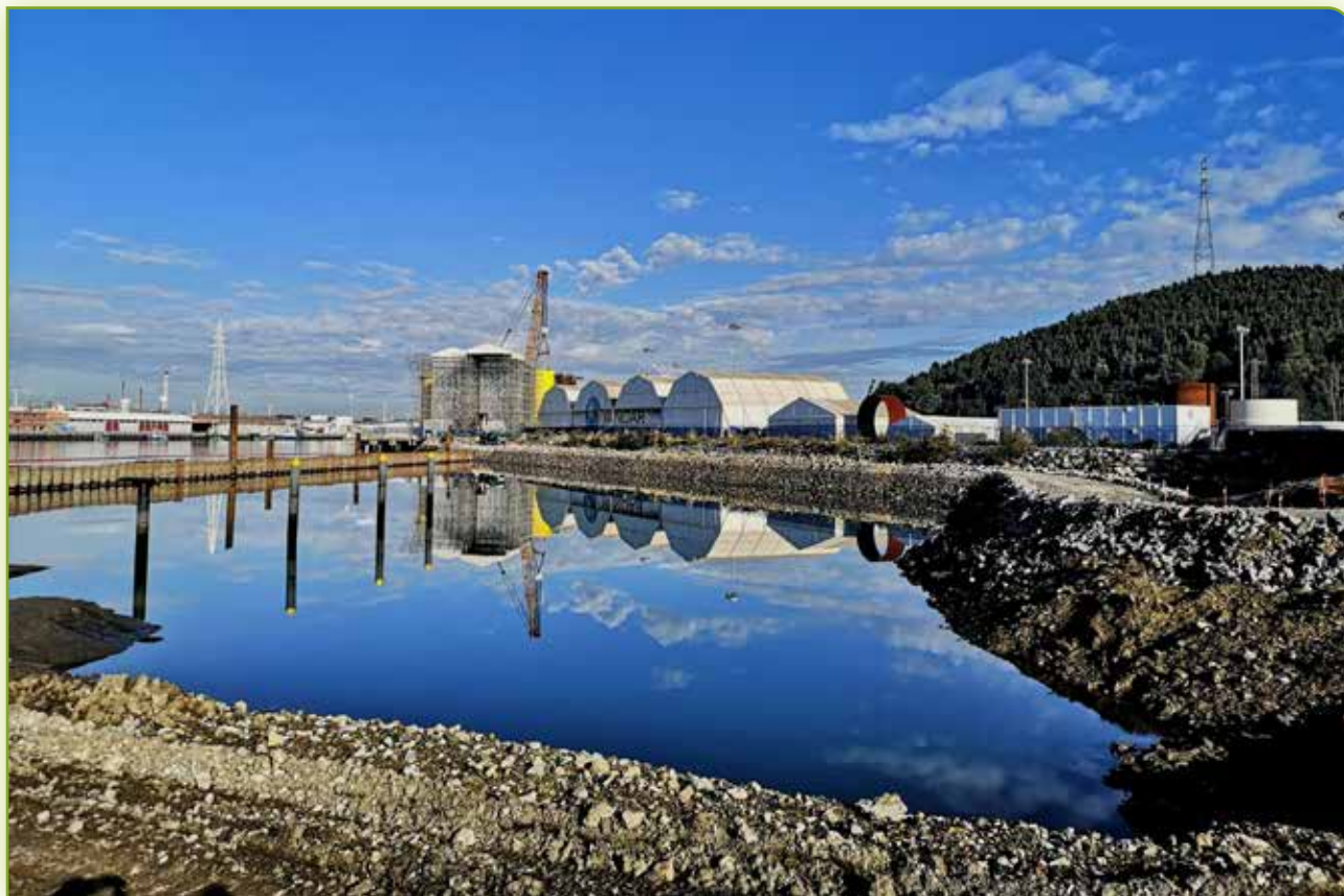
Durante las obras, Noviembre 2024.
