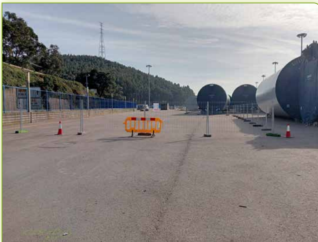
Antes de las obras. Before the works.
