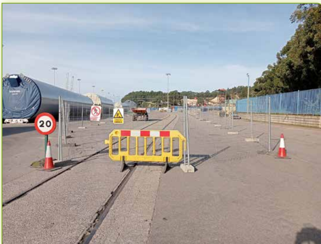
Tras la finalización de las obras. After completing the works.
