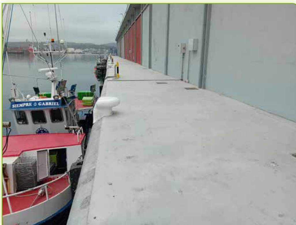
Tras la finalización de las obras. After completing the works.
