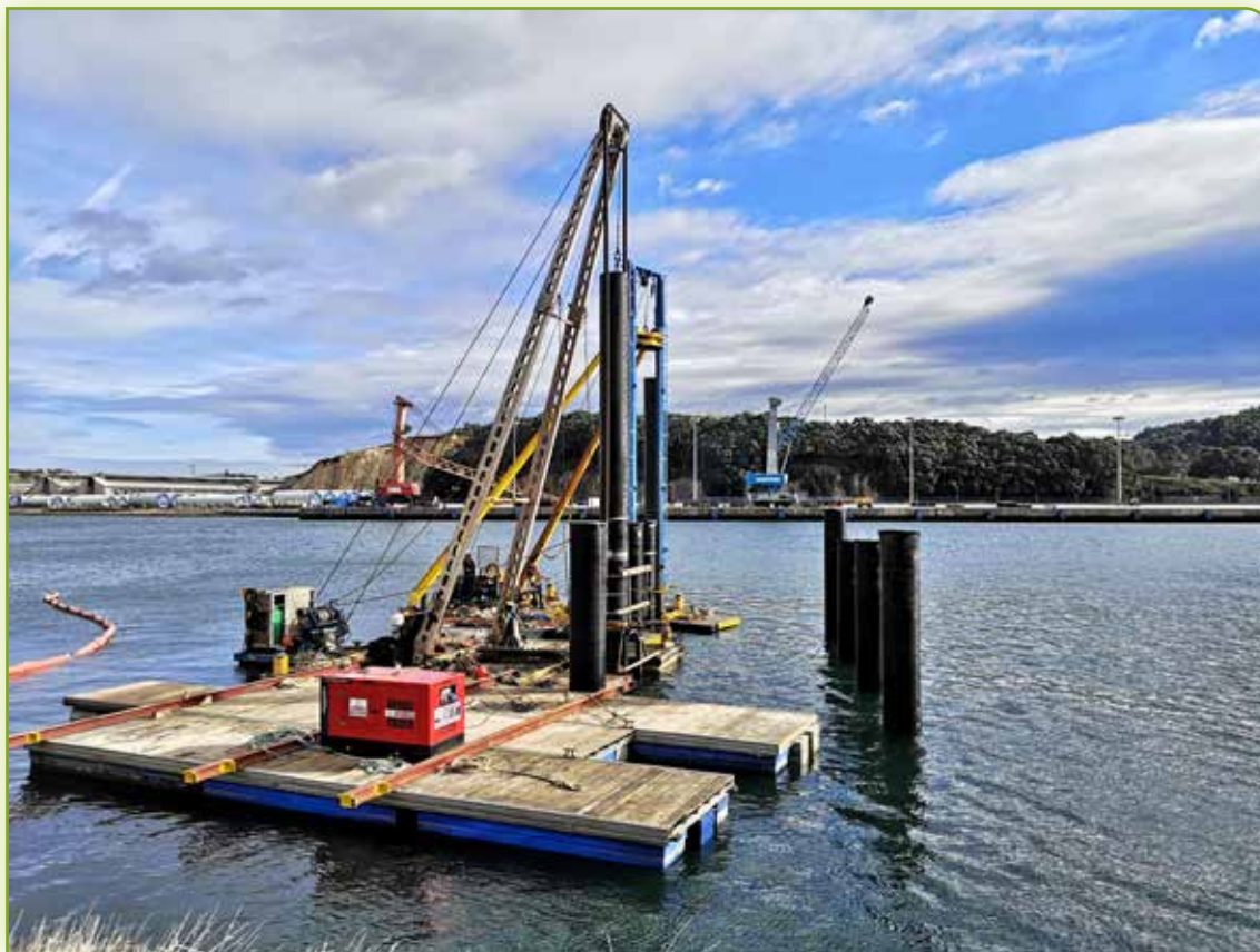
Durante la ejecución de las obras. Noviembre 2024.
