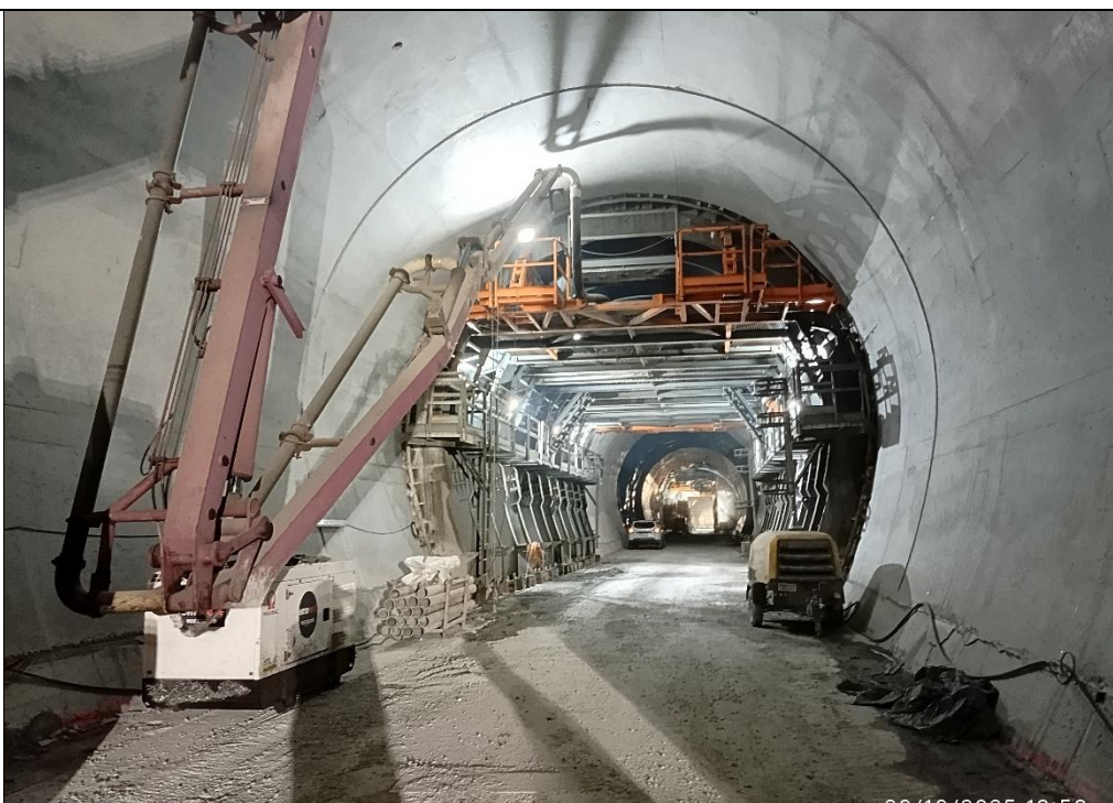
Revestimiento del Túnel 1
