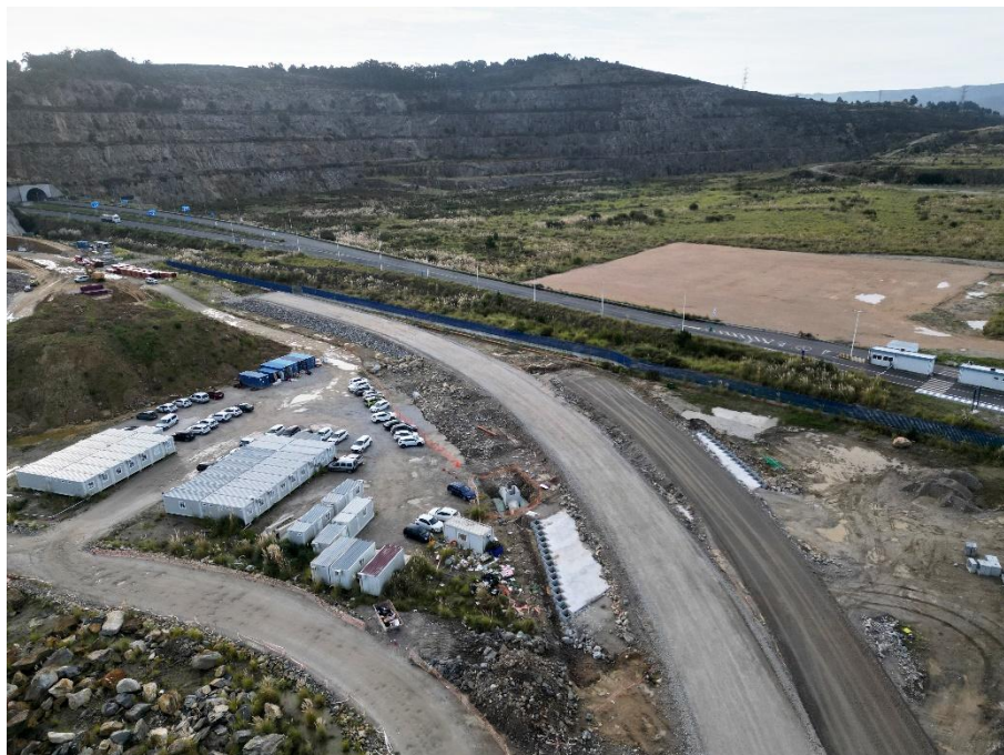
Tierras. Zahorra para refino de coronación de pedraplén. Zona ramal de prolongación y mango de maniobra
