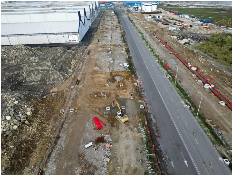
Arquetas de drenaje. Drenaje longitudinal y cruces transversales. M.I. Vial Norte.
