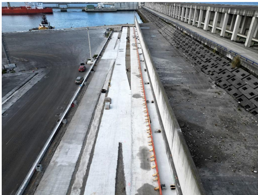
Hormigón de nivelación para losa de vía estuchada, canalización CMS, drenaje pluviales y prelasa de vía lateral (M.D.)
