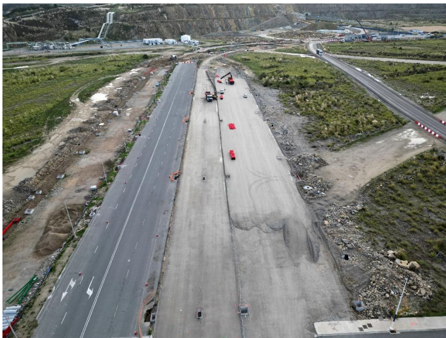
Tierras M.I. Vial Norte. Zorras para base granular de firme en vial de carga/descarga y para capa de forma de losa de vía estuchada (vías 5A y 7)
