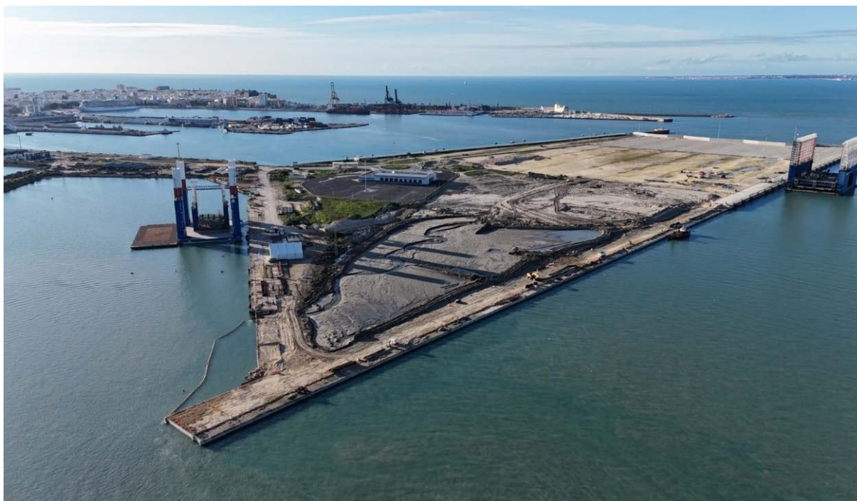
Vista general de las obras con el dique flotante para fabricación de cajones.
