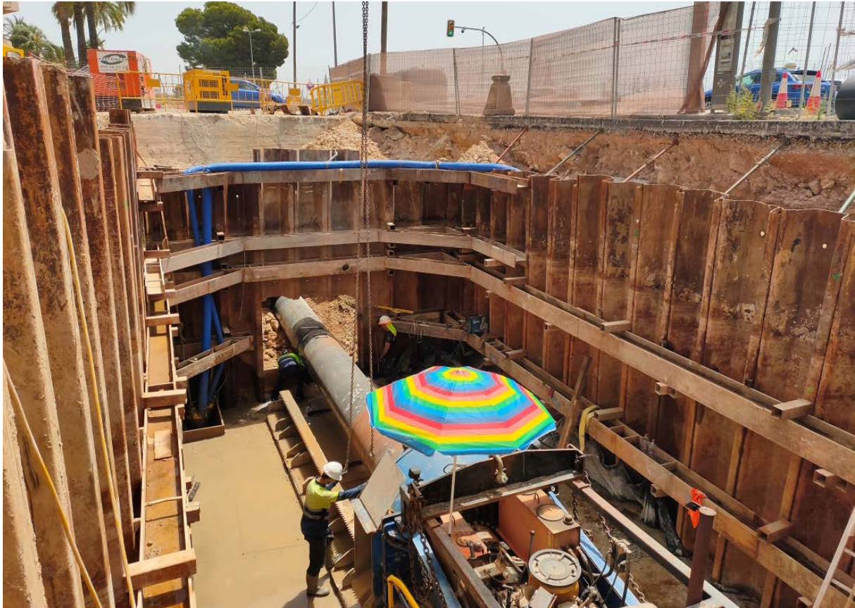
Pantalla de tablestacas para sostenimiento.
