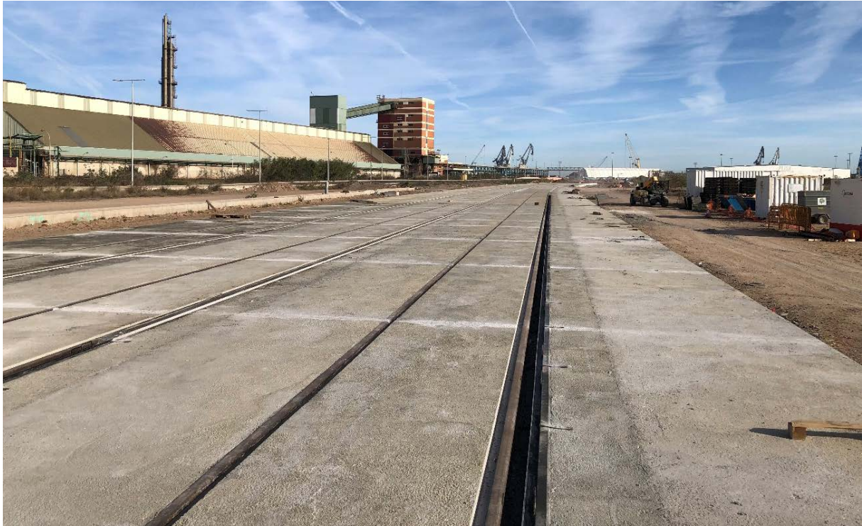
Vista de un tramo de vía en placa terminada.
