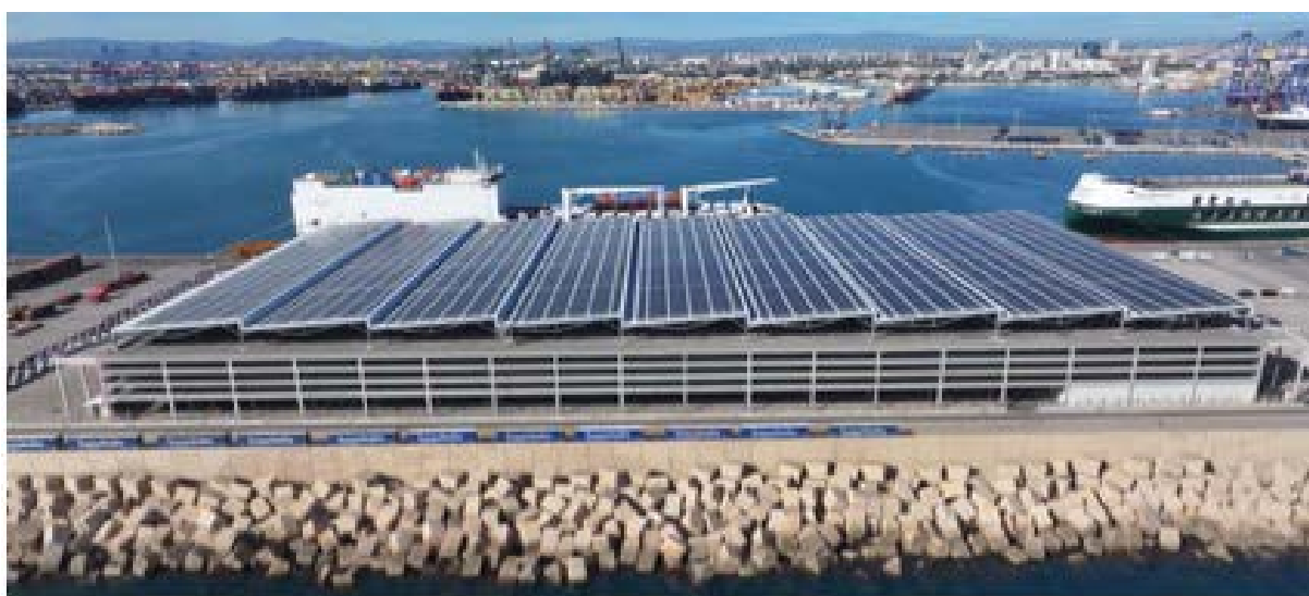
Silo de almacenamiento de vehículos con las placas fotovoltaicas ya dispuestas.
