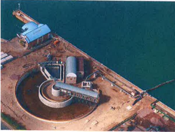
Fotografía 15. Sistema de decantación y bombeo de arena. Puerto de Durban [40]
