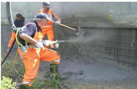
Fotografía 38. Aplicación de hormigón proyectado en Lyngby, Dinamarca. [142]
