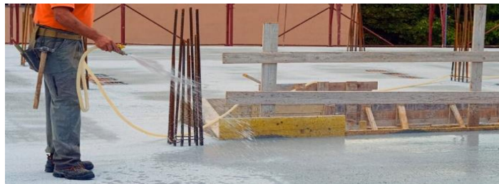
Fotografía 20. Curado superficial con agua por aspersión ( https://shutterstock.com )
