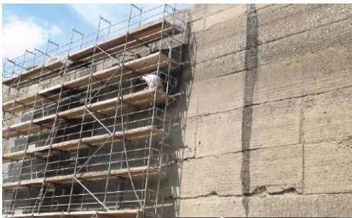
Fotografía 37. Obra de reparación de depósito de agua, en Thüringen, Alemania, con PSA mediante mortero proyectado. [168]
