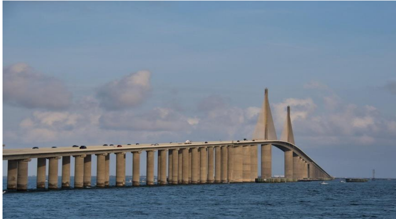
Fotografía 7. Tampa Bay's Sunshine Skyway Bridge (pixabay.com)
