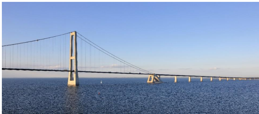
Fotografía 17. Puente Storebaelt (Martin Falbisoner. commons.wikimedia.org )
