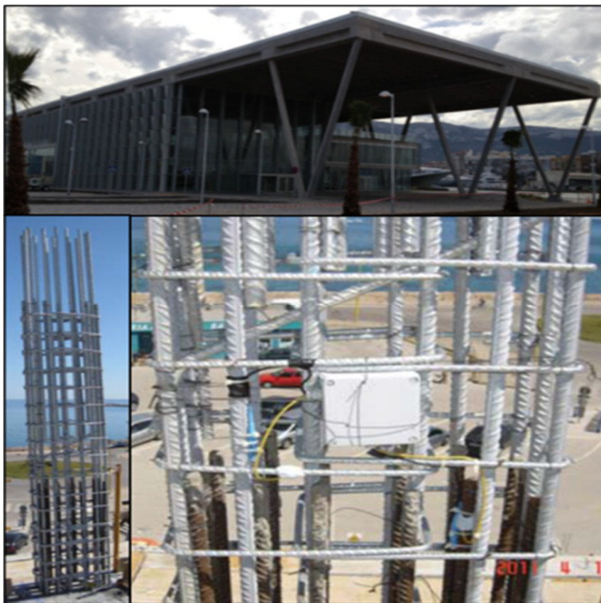
Figura 5: Estación marítima de Denia. Arriba, obra finalizada; abajo, detalles de la armadura galvanizada antes del hormigonado y del estudio de durabilidad realizado por el IETcc-CSIC © [17]
