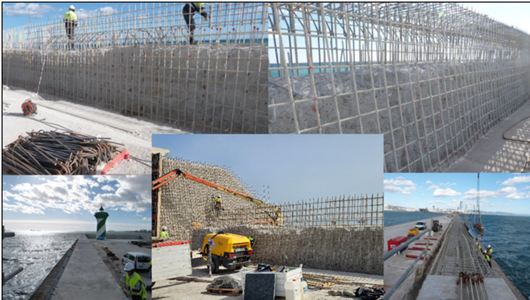
Figura 26: Espaldón en el puerto de Barcelona, en distintas fases del proceso de ejecución
