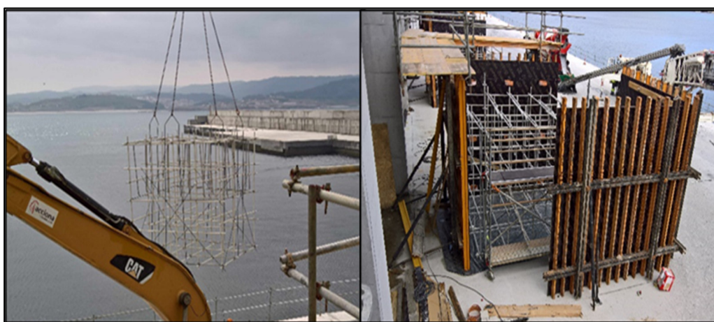
Figura 24: Punta Langosteira. Armadura GFRP en distintas fases del proceso de fabricación de los bloques
