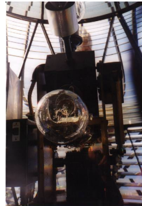
Fig. 4 Lámpara de filamento y cambiador de lámparas
