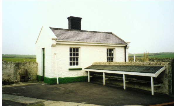
Fig. 11 Taller en el Faro de Nash Point. Actualmente, la sala de máquinas.
