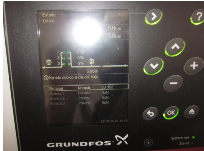
Figura 4.1.9 Interfaz del variador de frecuencia de los motores del grupo de presión del muelle Aragón
