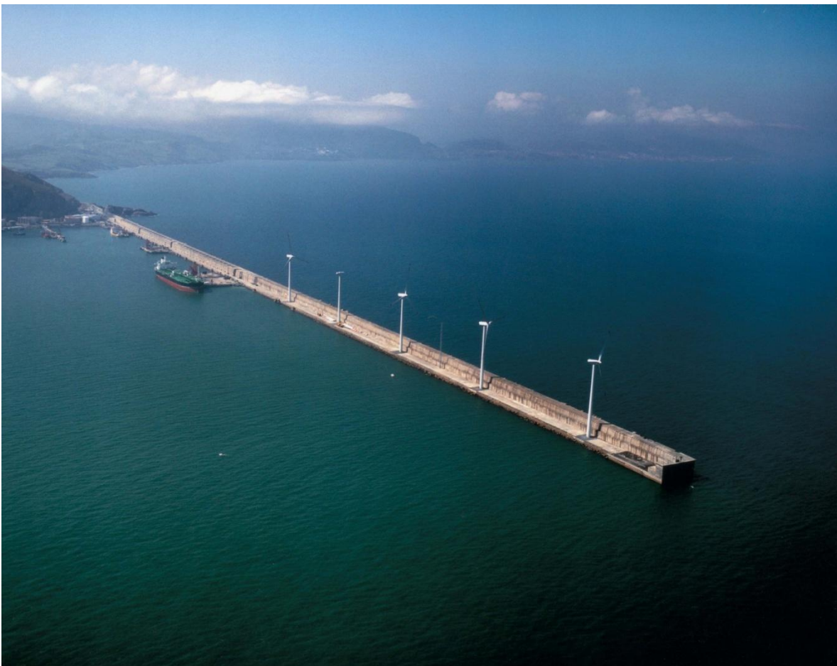
Figura 2.4.4 Vista aérea de aerogeneradores en el dique Punta de Lucero (Bilbao)
