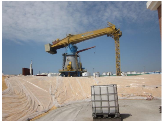
Figura 4.1.10 Zona de acopio de graneles en muelle
