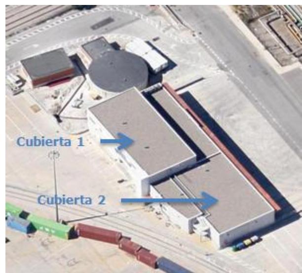
Figura 4.1.11 Cubiertas del PIF adecuadas para instalación fotovoltaica
