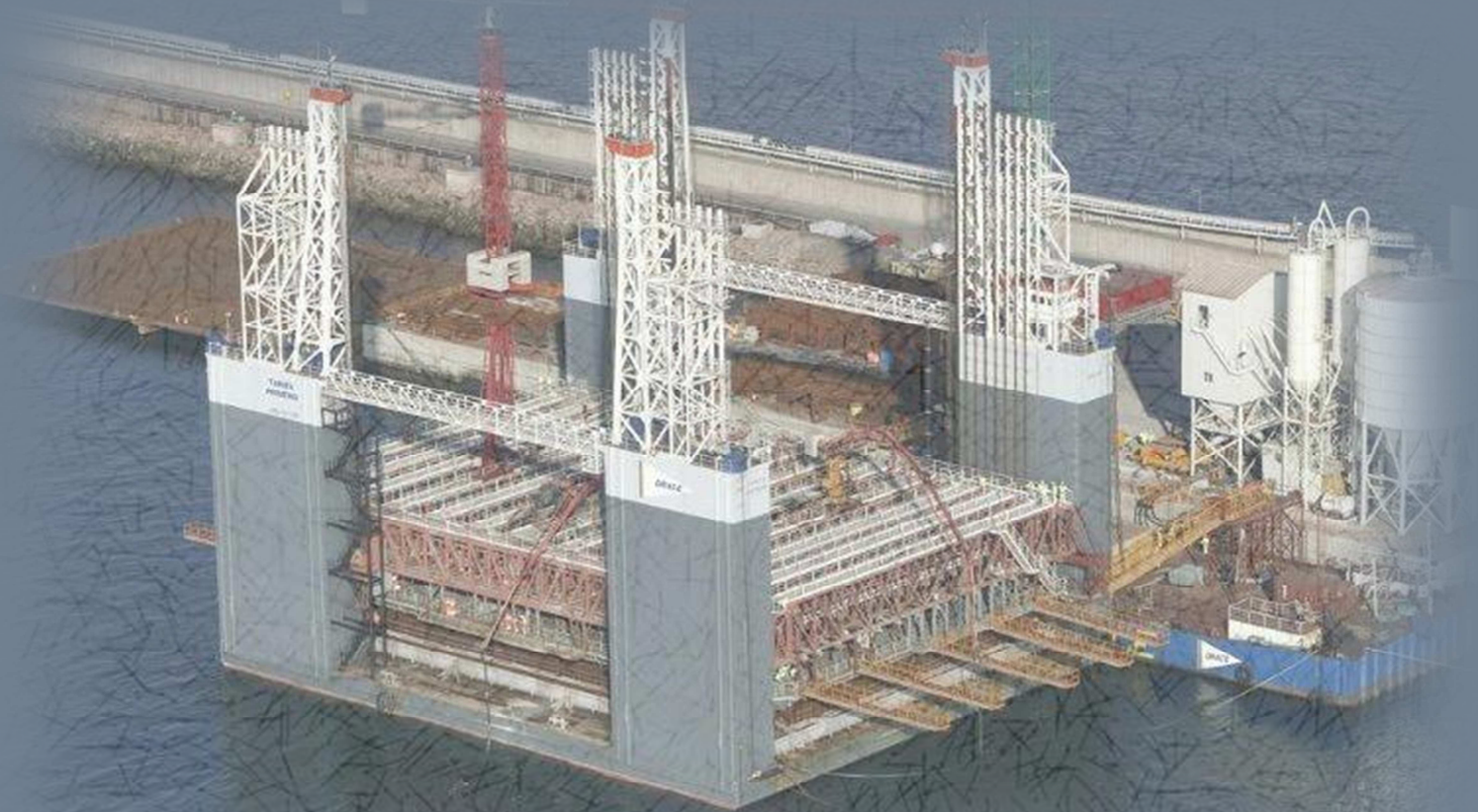
Dique flotante (Obras de ampliación del Puerto de Gijón)
