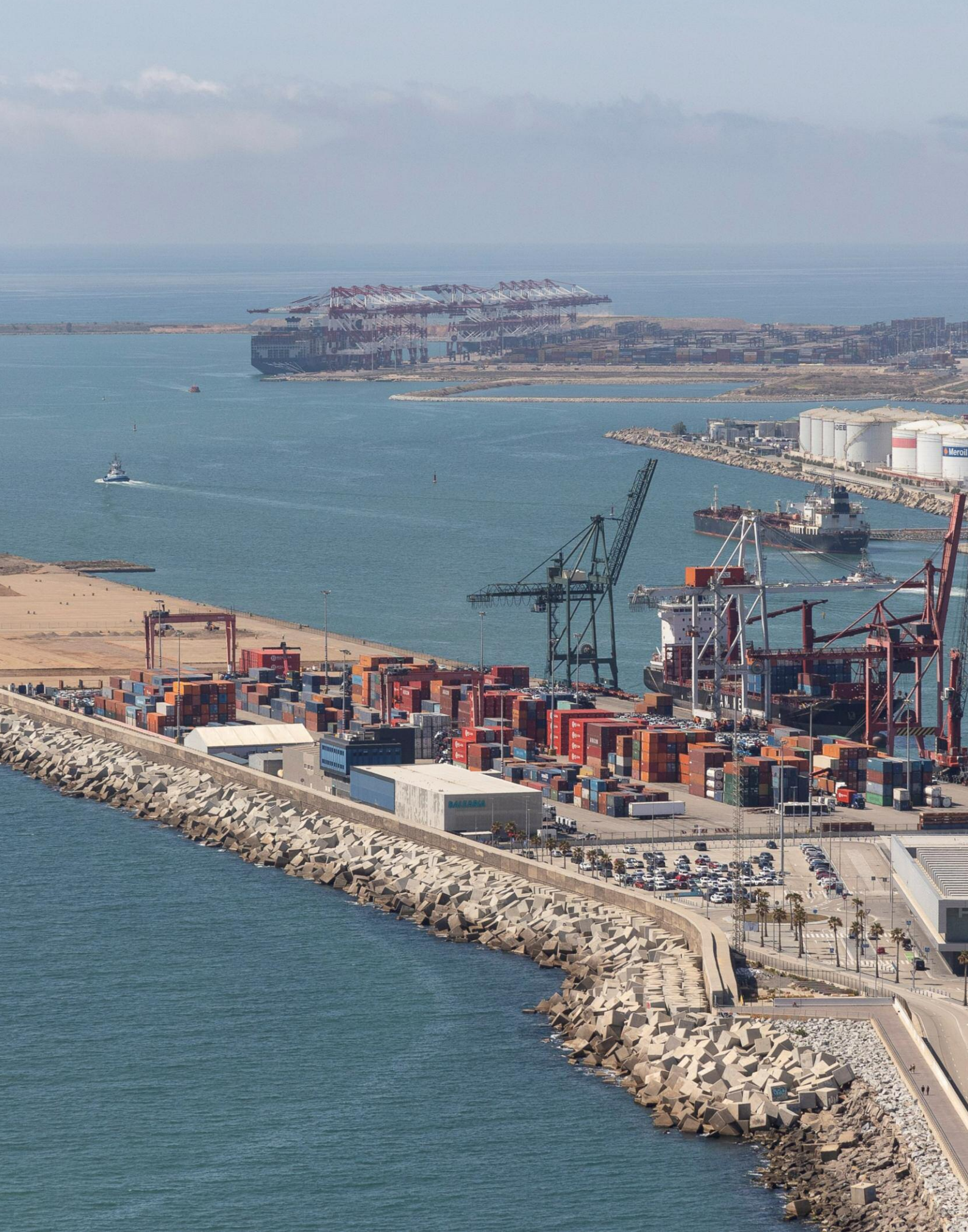
Muelle de la Energía (terminal de graneles líquidos) y Muelle Adosado (izquierda) en el puerto de Barcelona.
