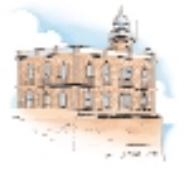
Faro de Mallorca (A.P. Mallorca) Período de construcción: año 1814
