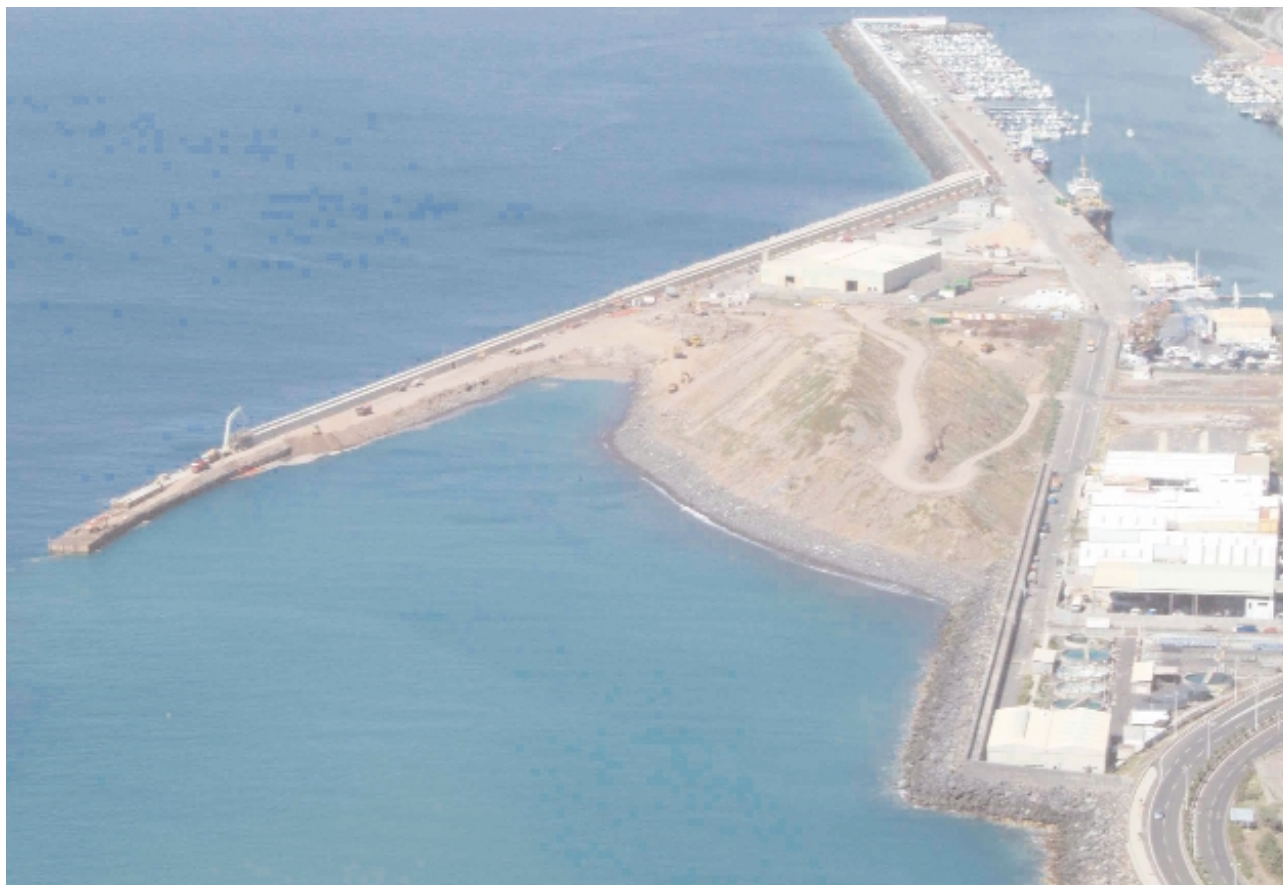
Obra: "3ª fase de defensa del ensanche de la explanada de la dársena de pesca del puerto de Santa Cruz de Tenerife"
