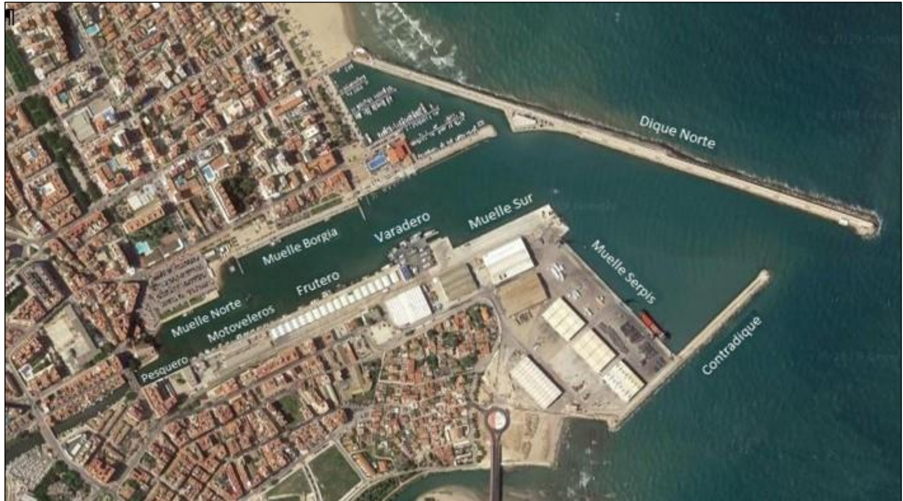
Figura 2: Obras de abrigo (Diques) y Muelles del Puerto de Gandía
