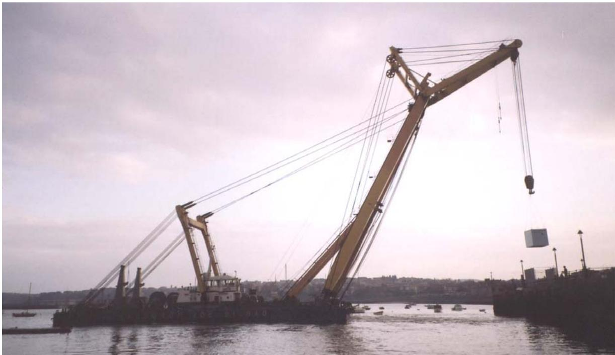
Figura 02. Instalación de la cabina de control de la calidad del aire en el puerto de Bilbao, mediante cabria flotante.
